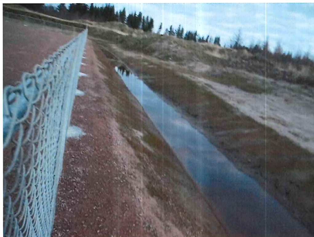
Photo 5 : Canal de rétention autour du site
