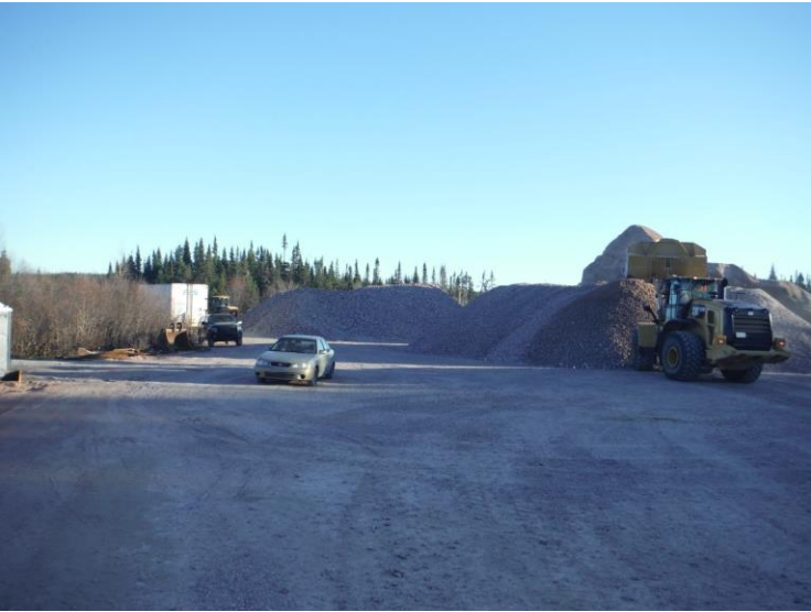
Photo 6 : Activités sur le chantier
