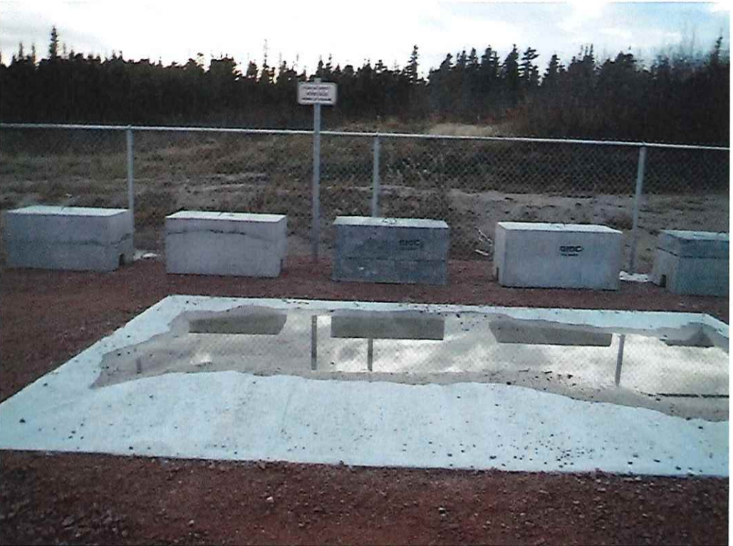
Photo 3 : Zone de VHU avec plaque de démantèlement
