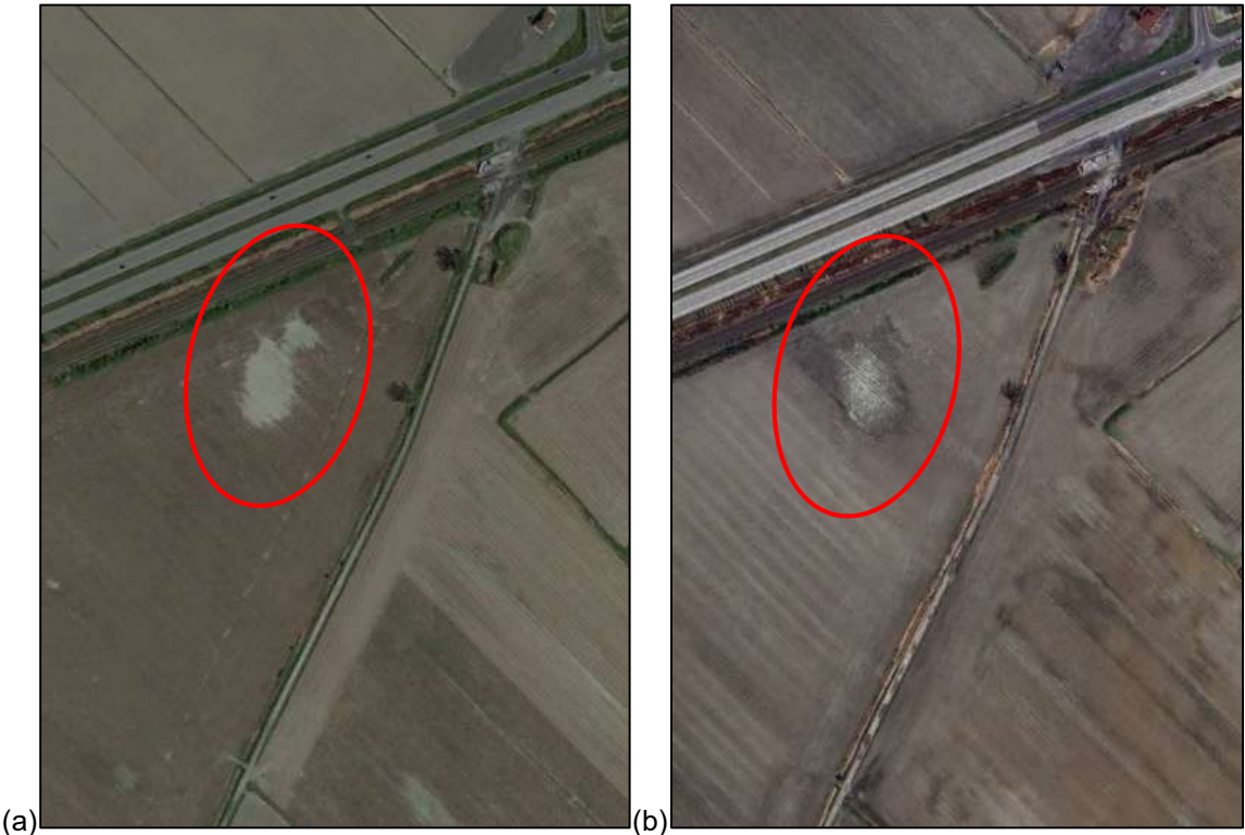
Figure 17. Images satellites récentes montrant la zone d'accumulation d'eau au nord-ouest de la branche 3 du cours d'eau Deslauriers, encerclée en rouge (Google Earth®). (a) image satellite du 27 avril 2023. (b) image satellite du 16 mai 2017.
