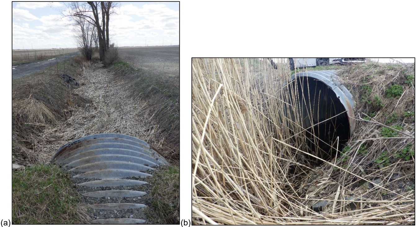
Figure 19. Ponceau reliant le fossé du chemin de fer du Canadien National avec la branche 3 du cours d'eau Deslauriers. (a) vue à partir de l'aval du ponceau vers la branche 3. (b) Vue vers l'amont du ponceau.
