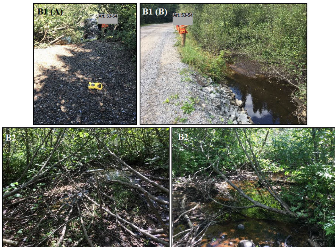
Figure 4 : Section B, comprend B1 (A) en aval du ponceau de la rue Gingras et (B) en amont du ponceau ainsi que B2.
