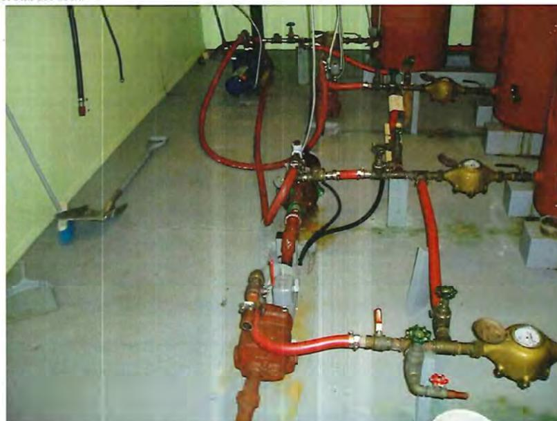
Vue des pompes et compteurs d'eau. On remarque la propreté du plancher et l'absence de taches pouvant résulter de fuites.
