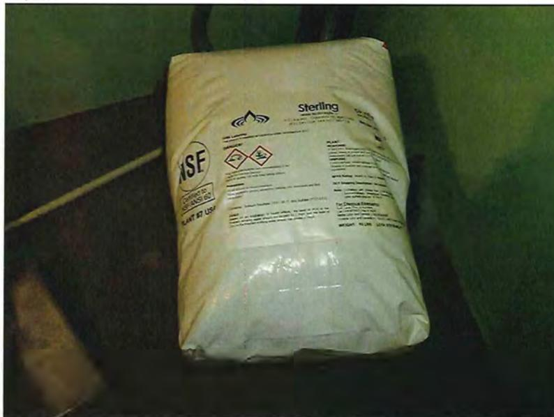
Bisulfates de sodium et sulfate de zinc en poudre qui est occasionnellement ajouté à l'eau manuellement pour l'acidifier et probablement faire précipiter le fer et/ou le manganèse lorsque l'eau est trouble. NSF 60. L'opératrice n'en a jamais utilisé.
