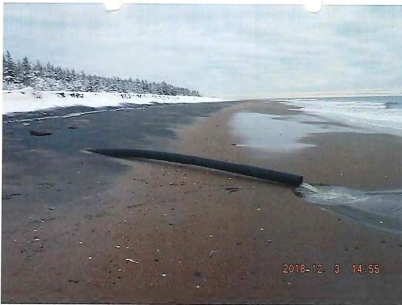
Émissaire sectionné rejetant les eaux usées dans la zone de marnage. Bloc de plomb du côté gauche près de la limite des dernières hautes eaux.
