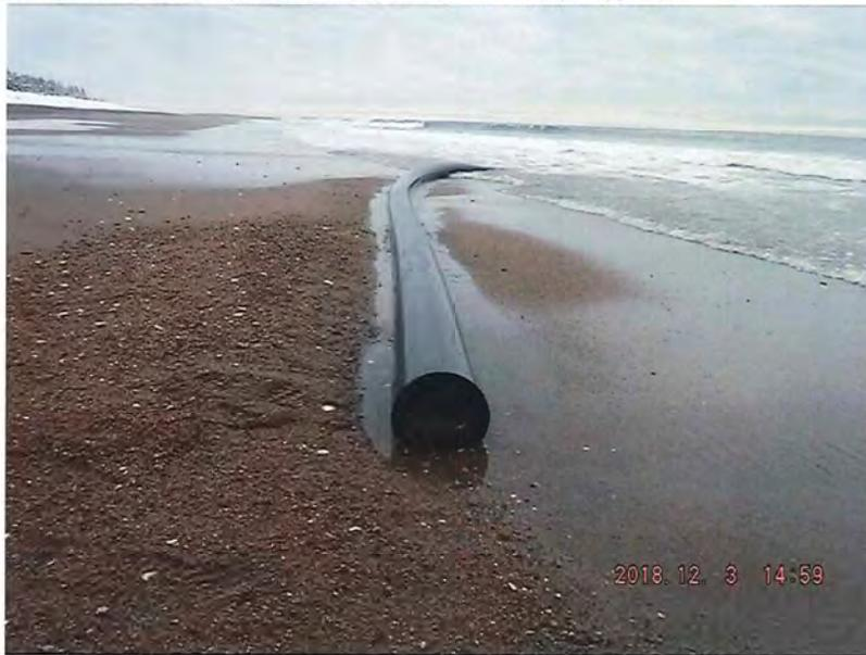
Vue de la section aval (coupure nette sans aspérité). Présence de sable dans le conduit.
