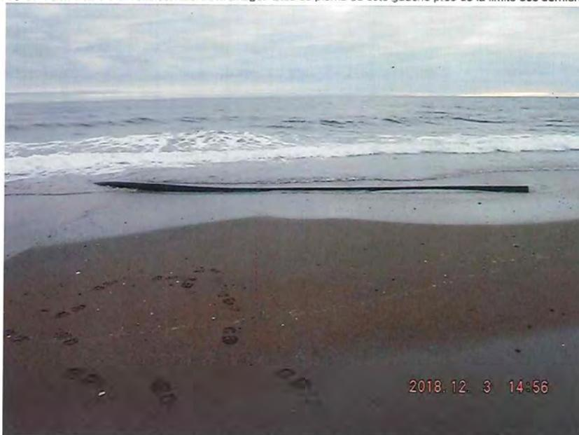
Vue de la section aval débranchée de l'émissaire. Les vagues l'ont rempli de sable et elle doit être vidée pour être manipulée plus facilement.
