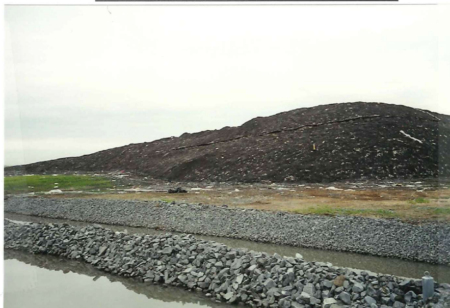
Photo # : 7 Date 2001-05-04 Ident. : ADM entreposage des neiges usées « Côté ville » Note : Bassin de décantation et partie du bassin de rétention séparés Par un muret de pierre
