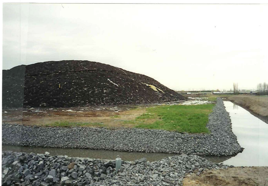
Photo # : 6 Date : 2001-05-04 Ident. : ADM entreposage des neiges usées « Côté ville » Note : Bassin de décantation entourant la zone d'accumulation des neiges
