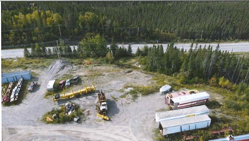
Image 05 entreposage de VHU sur le terrain du MRNF sans bail de location
