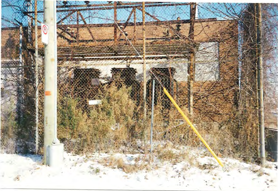
Photo # : 1 Date : 2000/12/08 Ident. : 5600 rue Paré
