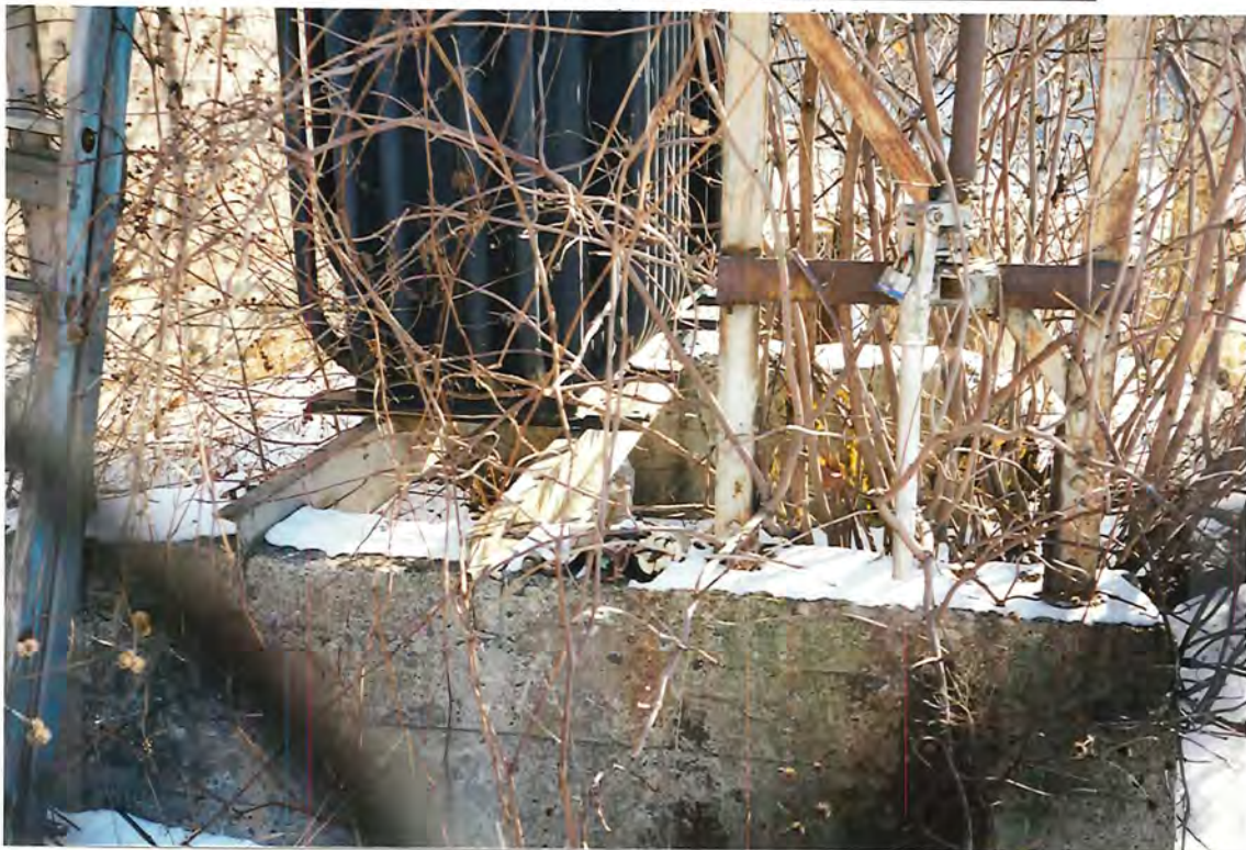
Photo # : 2 Date : 2000/12/08 Ident. : 5600, rue Paré
