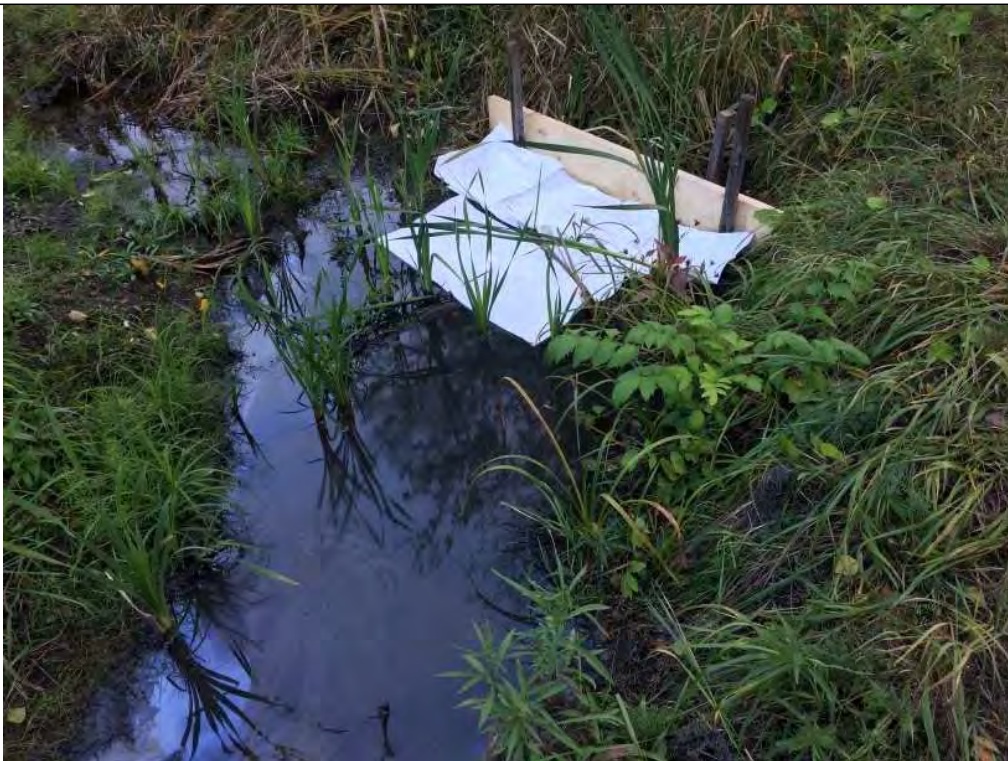
Photo 4: estacage en bois avec couches absorbantes
