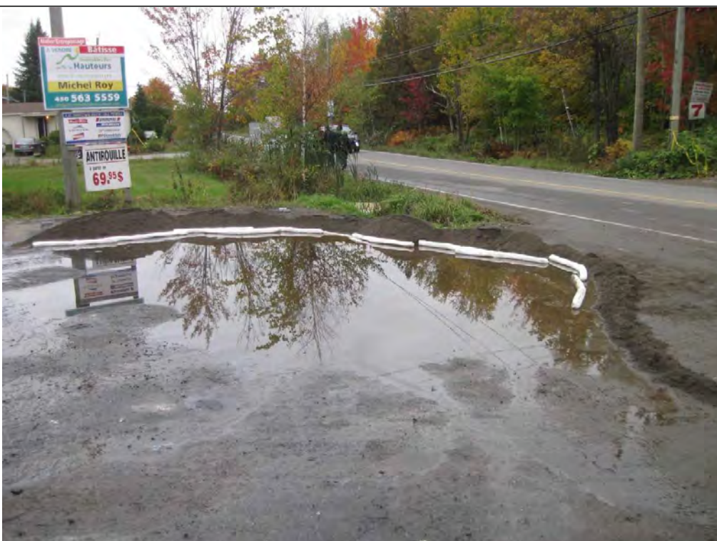
IMG_0831.JPG Photo 3: digue de sable avec boudins absorbants
