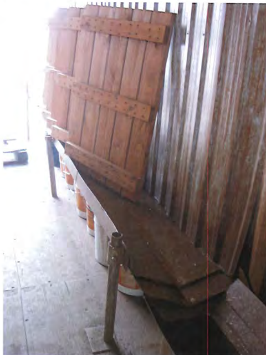
IMG_4442.jpg À l'intérieur du conteneur, il y a un support métallique en forme d'auge sur lequel les morceaux de bois des quais sont teints
