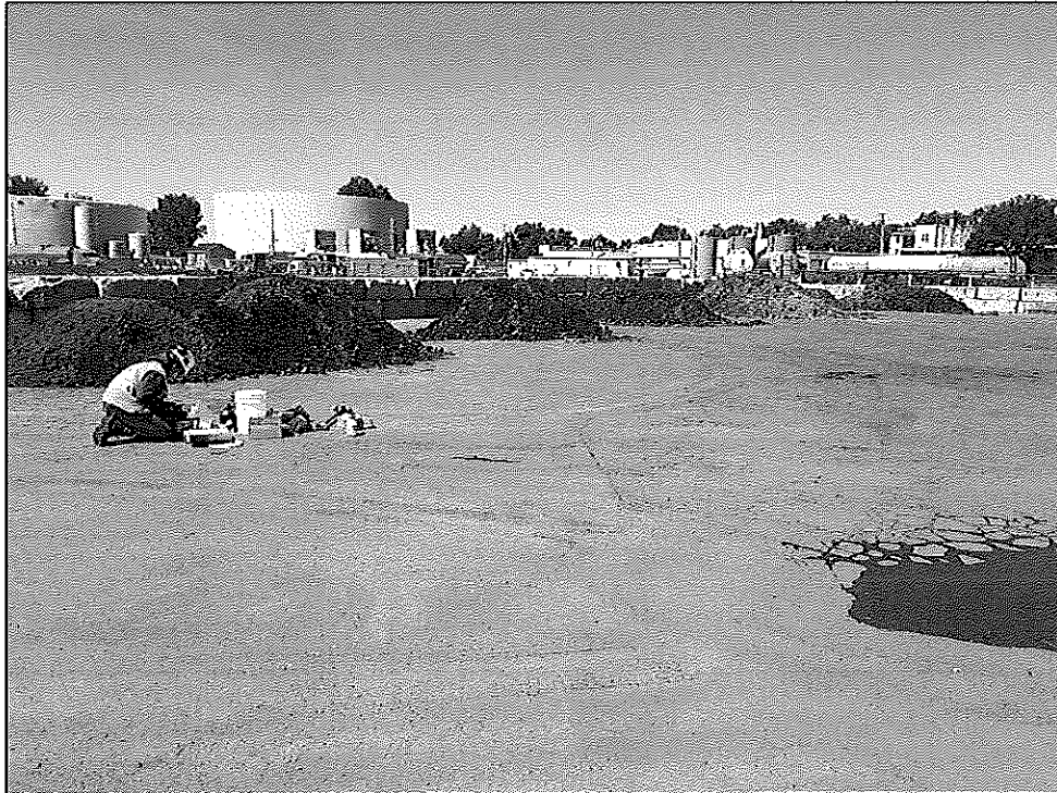
Photo n° 1 Vue des piles 1 à 6
