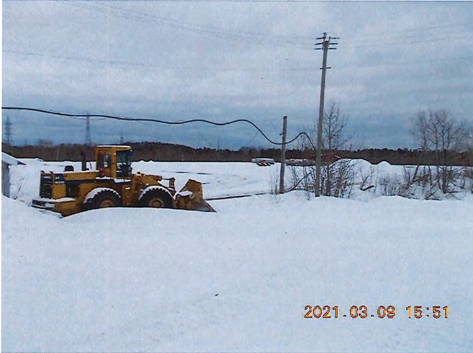
DSCN1394.JPG – Plateforme #3 – Voir site #1 annexe 1
