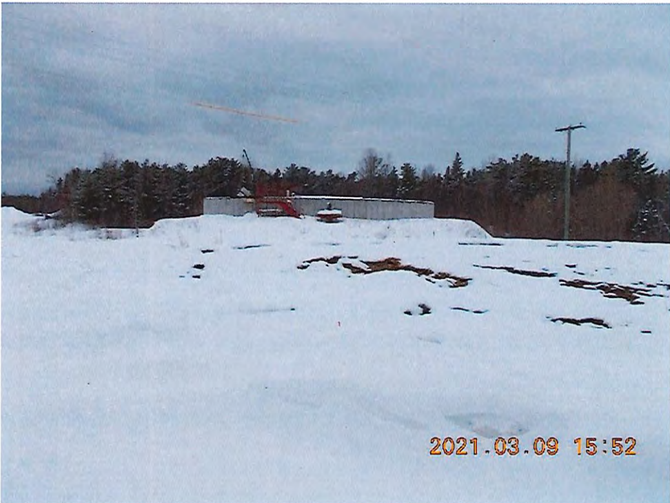
DSCN1395.JPG – Bassin d'aérateur – Voir site #2 annexe 1
