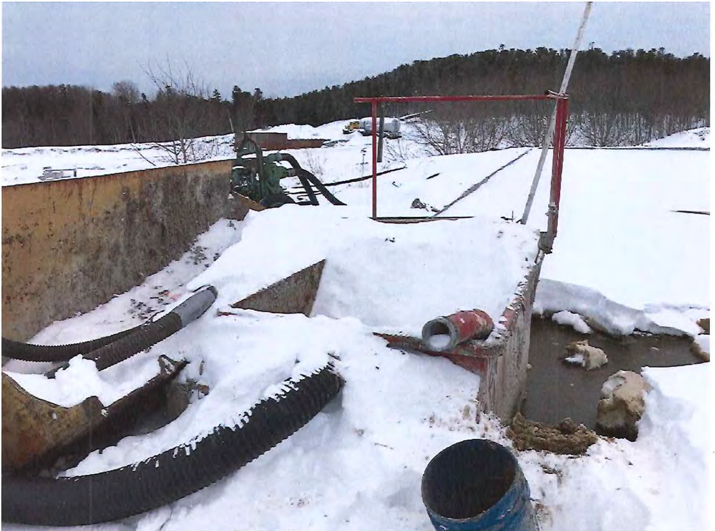
IMG_0286.JPG - Voir photo #4 annexe 3 Bassin de béton boues de fosse septique
