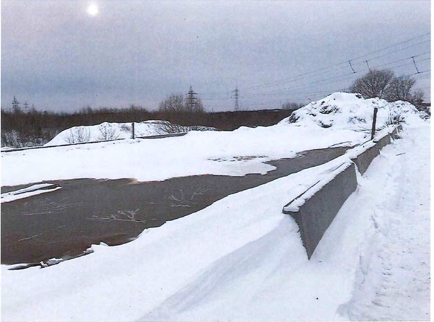
IMG_0287.JPG - Voir photo #5 annexe 3 Bassin de béton boues de fosse septique
