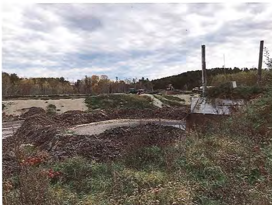
IMG_0160.JPG - Voir site de photo #8 annexe 1 Boues et trappe à graisse
