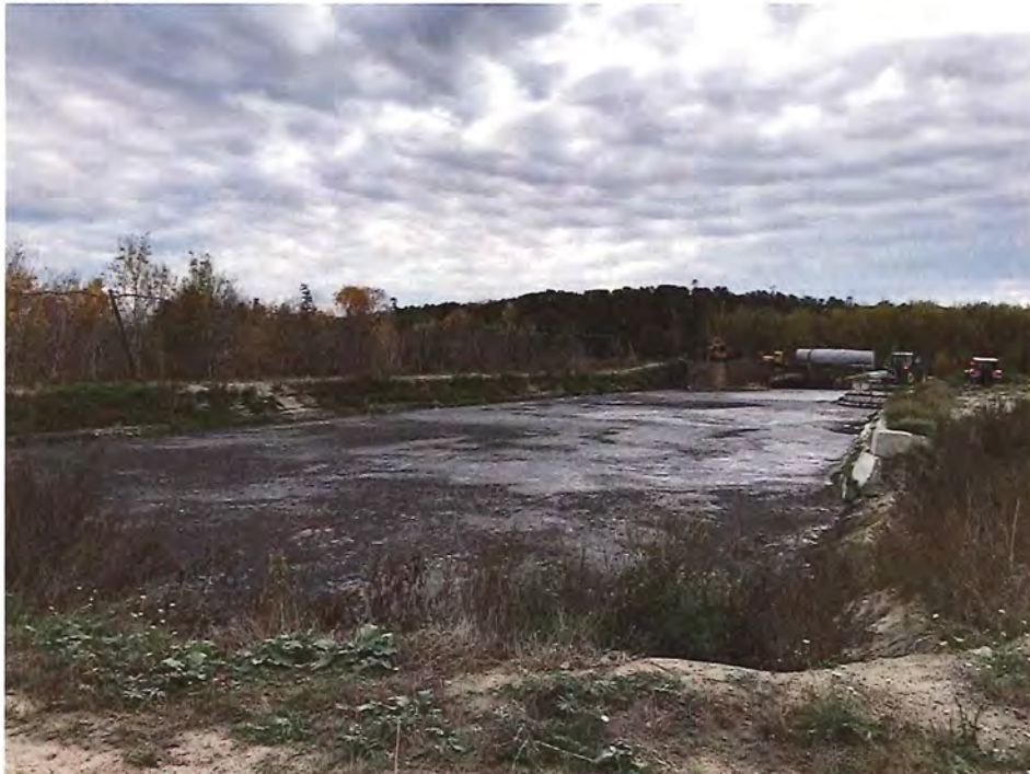
IMG_0164.JPG - Voir site de photo #10 annexe 1 Bassin d'accumulation des boues
