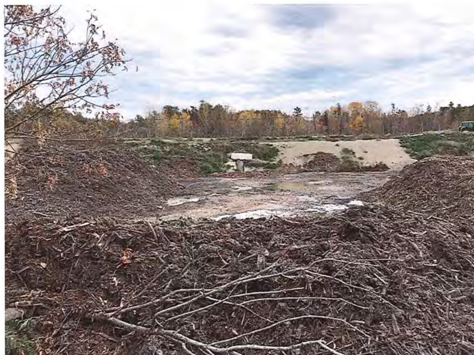
IMG_0161.JPG - Voir site de photo #9 annexe 1 Andains sur les murs internes
