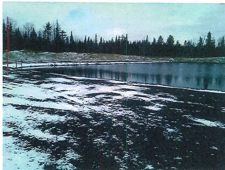
DSC00186.JPG Bassin de stockage du lixiviat, rempli à capacité.
