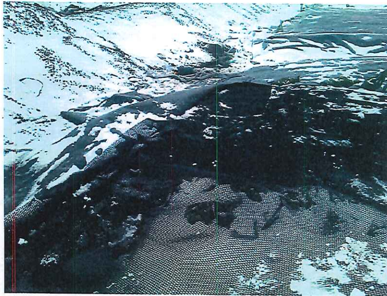
DSC00184.JPG Membrane non fusionnée, dans la cellule 4 en construction.
