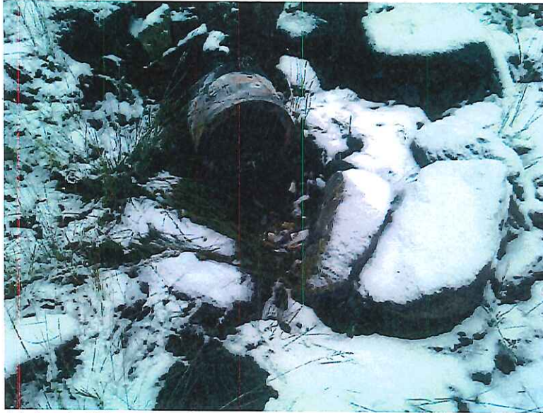
DSC00171.JPG Sortie du drain pluvial, dans le BS1.
