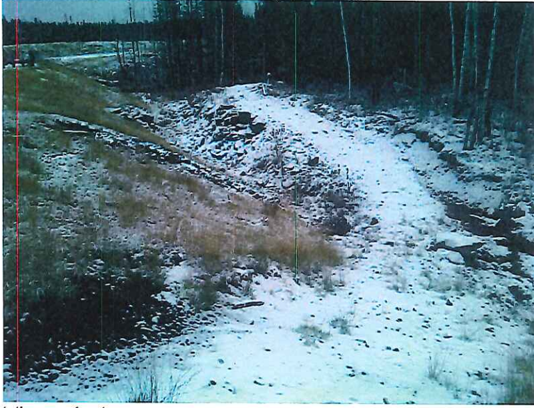
DSC00169.JPG Bassin de sédimentation numéro 1
