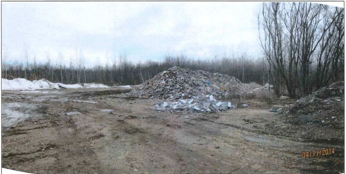
panorama2.JPG Béton, béton armé, briques ect.
