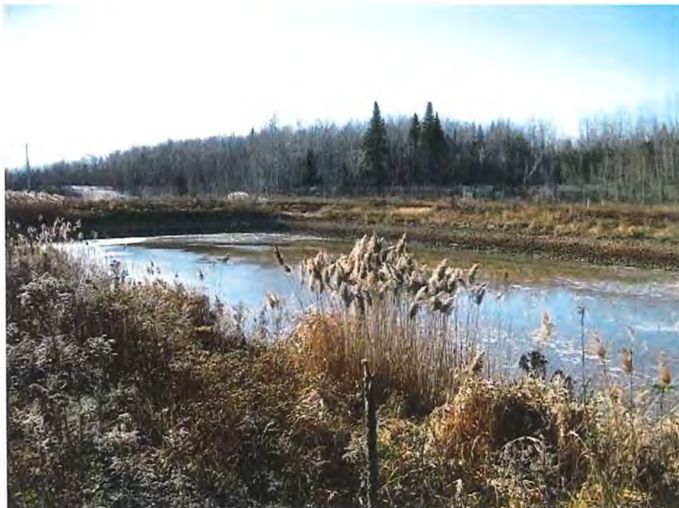
IMG_4580.JPG Image 6. Vue du bassin d'accumulation du lixiviat.
