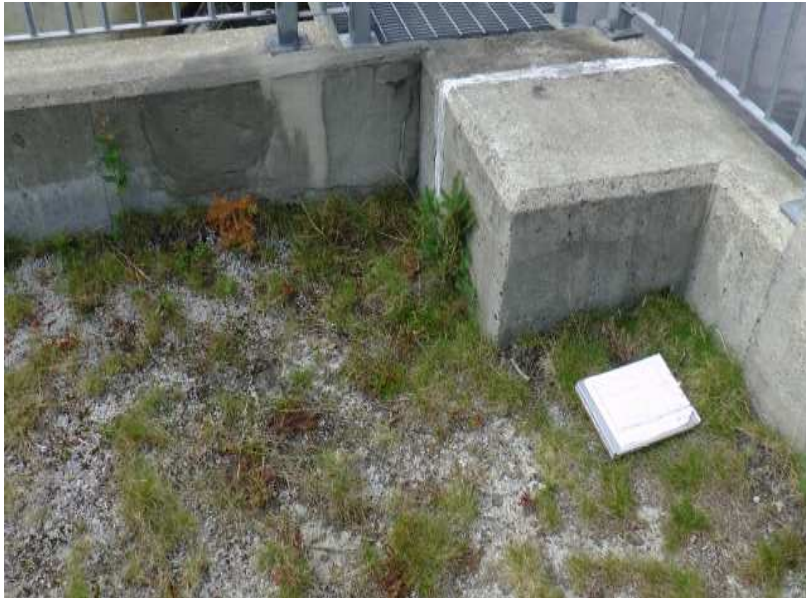
Crête de l'aile gauche à la jonction avec la partie centrale.
