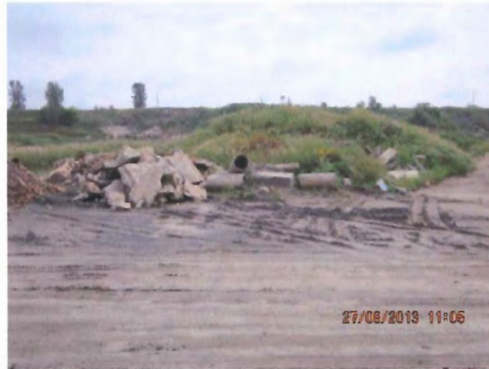
Photo 7 : IMG_1530.jpg : Amas de béton au nord
