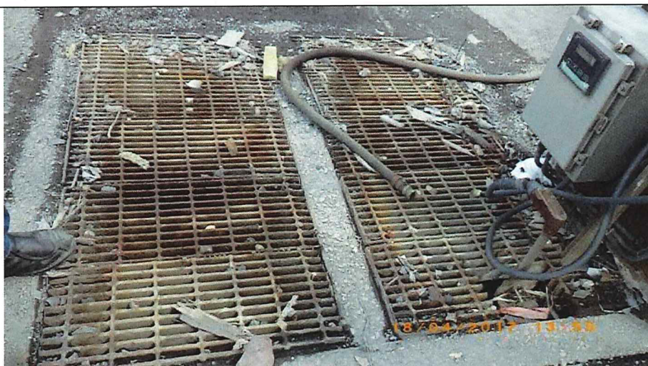
Photo 3 : Drain dirigeant les eaux et les acides vers l'usine de traitement d'acide faible.
