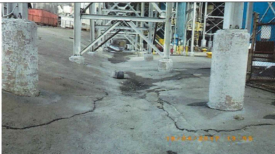
Photo 4 : Profile du terrain empêchant les eaux de ruissellement et les acides vers le drain dirigeant les eaux vers l'usine de traitement des acides faibles.
