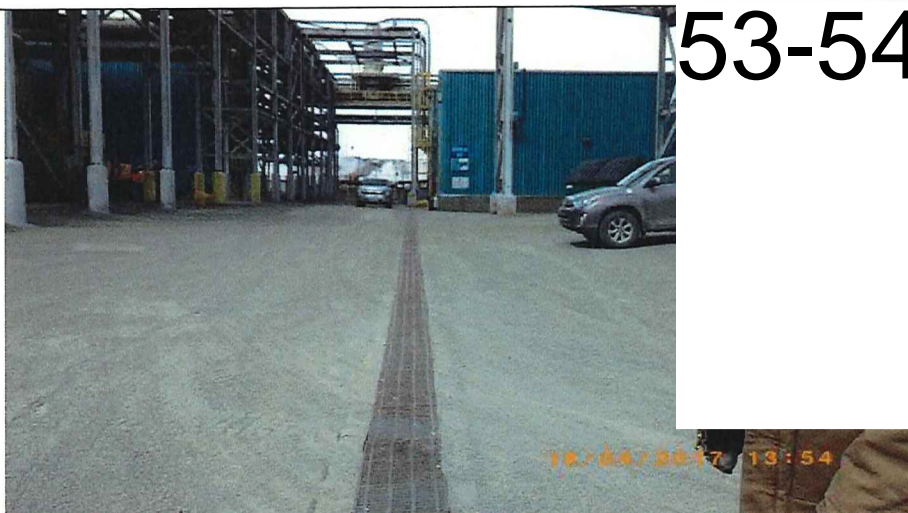
Photo 2 : Caniveau dirigeant les eaux et l'acide vers le drain dirigeant vers l'usine de traitement des acides faibles.
