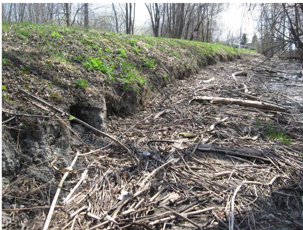
Photo 2 : Érosion importante dans le secteur de la promenade en bois
