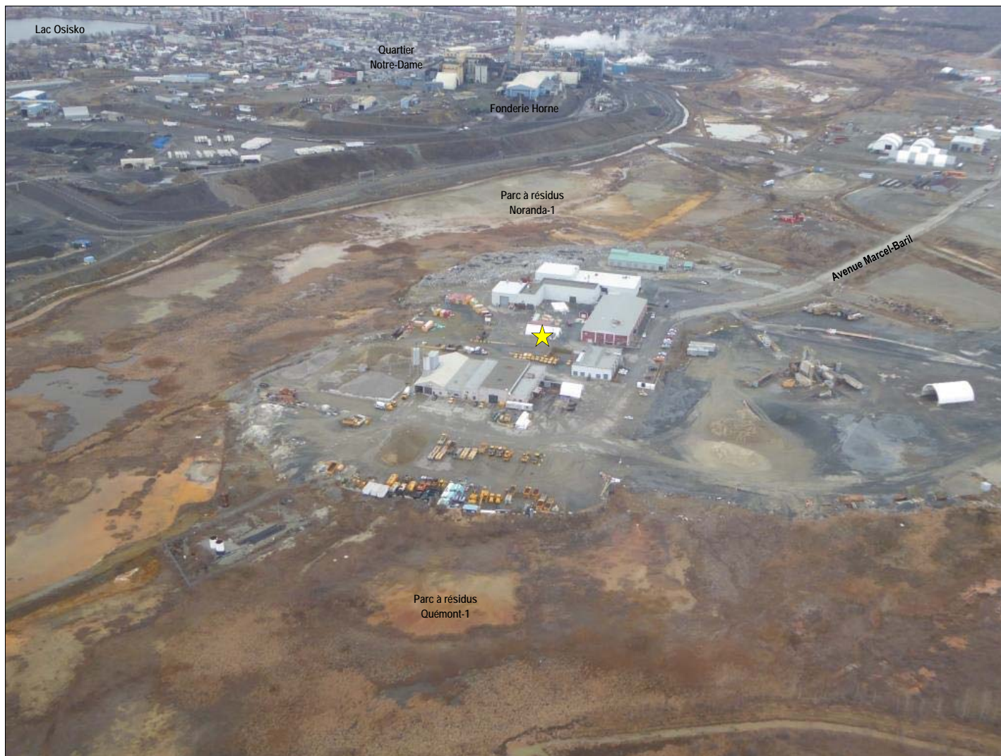
Photo 2 : Vue aérienne du secteur d'implantation du projet
