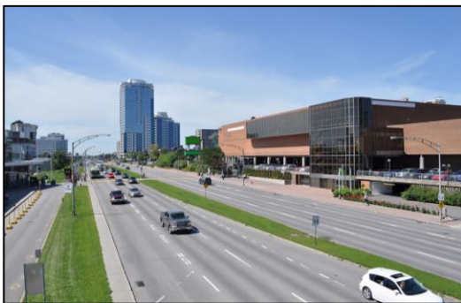
Figure 7.3 Simulation visuelle d'insertion sur le boulevard Laurier, milieu non restreint – Avec trois voies automobiles dans chaque sens et banquettes arborées séparant la plateforme du SRB
