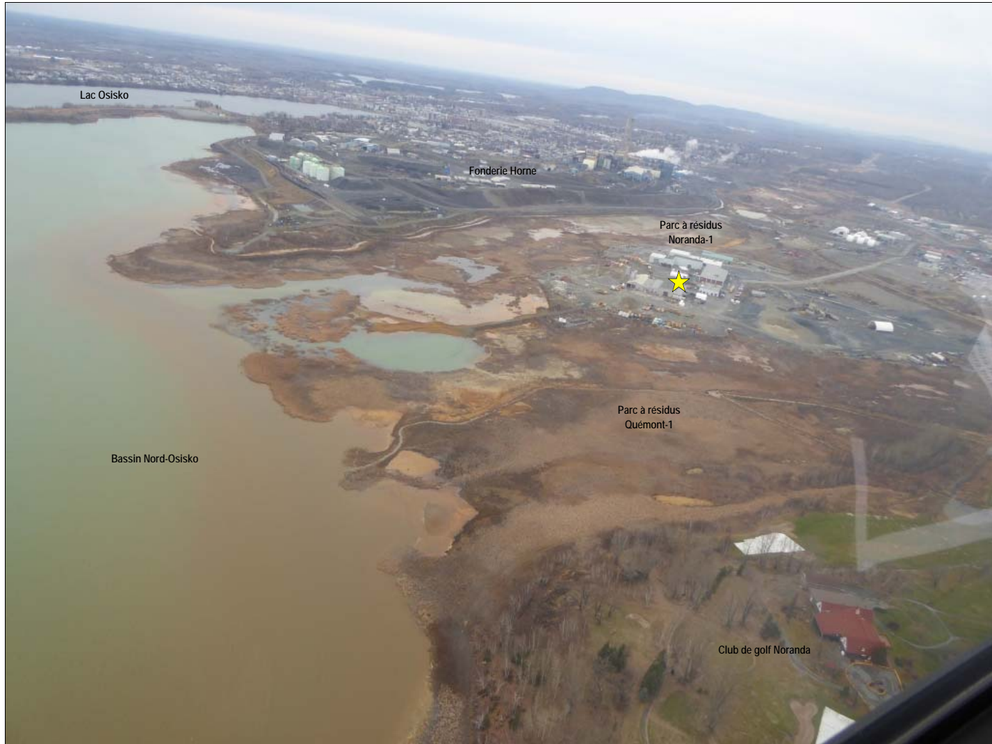
Photo 3 : Vue aérienne du secteur d'implantation du projet
