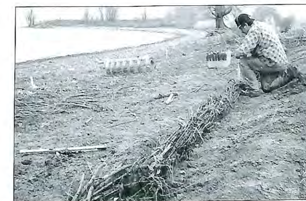
Les fagots sont déposés dans une tranchée et solidement fixés au sol à l'aide de tiges métalliques.
