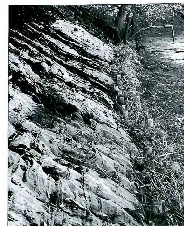
Généralement, une seule rangée de fascines est appliquée dans le bas d'un talus.
