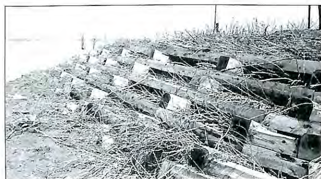
Les branches de saule sont insérées entre les différents étages du caisson.
