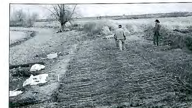
Les branches de saule sont appuyées contre le sol à l'aide d'un treillis métallique.
