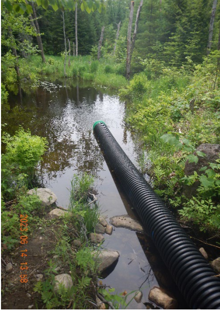
X0004983_2023-06-14 (33).JPG Image 13. Conduite de l'aile gauche, vue de l'aval
