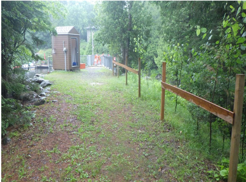
Photo #7: Installation de poteaux et de planches de bois faisant office de clôture et plantation de petits arbres sur la rive aval droite.
