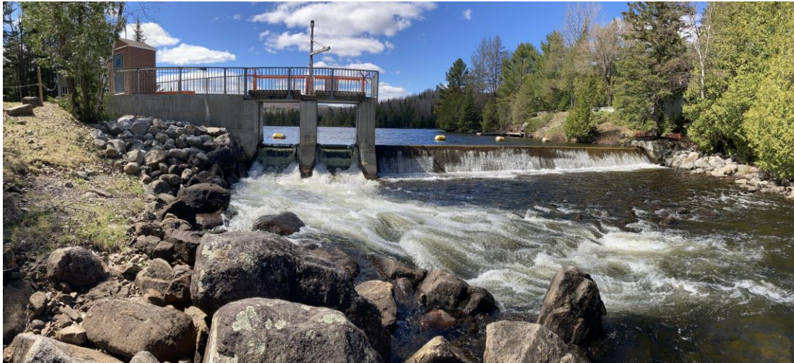
Photo 2-1 : Barrage Théodore – Vue de l'aval
