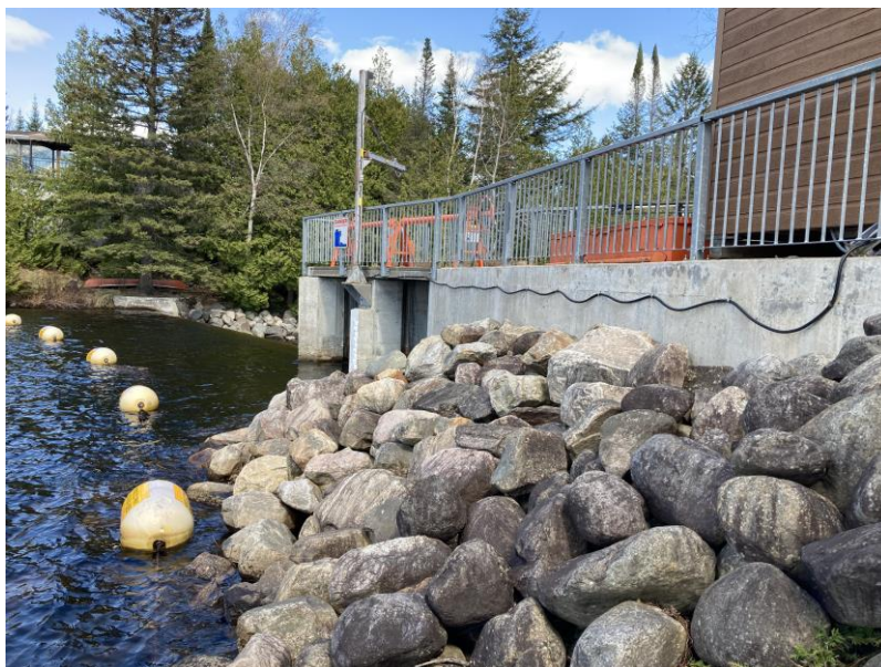
Photo 2-2 : Barrage Théodore – Vue de l'amont
