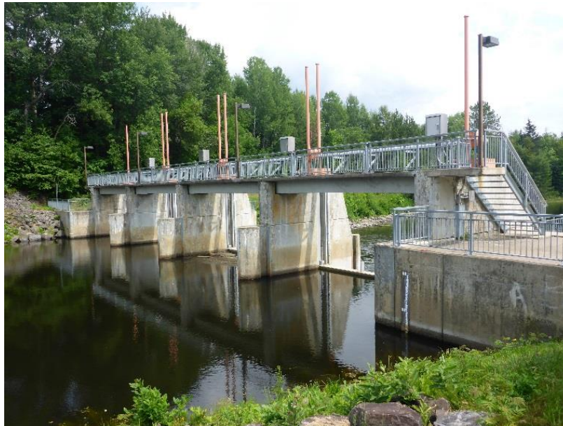
Photo 2-1 : Barrage Saint-Didace – Vue de l'amont
