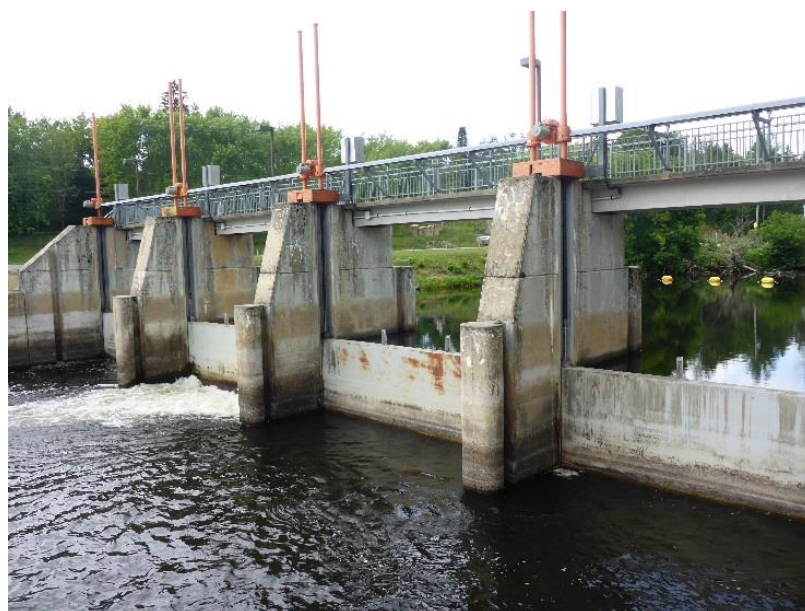
Photo 2-2 : Barrage Saint-Didace – Vue de l'aval
