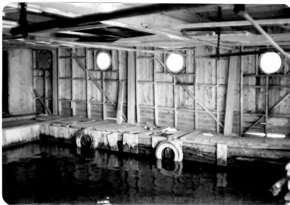
PHOTO 2 : Quatre poutres d'acier constituent principalement la charpente de la remise.
