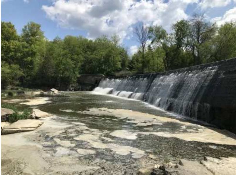
Vue de la face aval du déversoire
