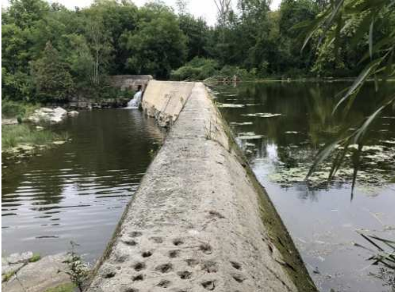
Vue générale du déversoir
