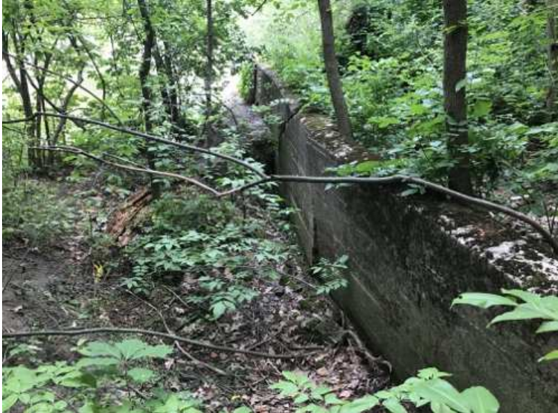
Mur de culée en rive gauche
