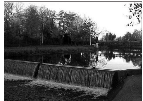
Photo 4 : En présence d'un ouvrage de retenue, la ligne des hautes eaux correspond à la cote maximale d'exploitation
