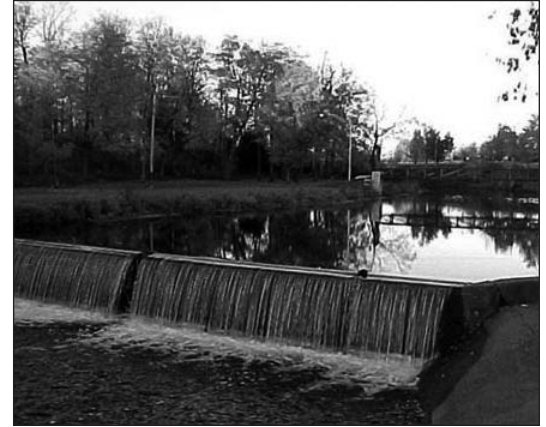
Photo 27 : Ligne des hautes eaux, en présence d'un ouvrage de retenue, correspond à la cote maximale d'exploitation
