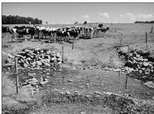
Photo 18 : Aménagement d'une traverse à gué pour le bétail
