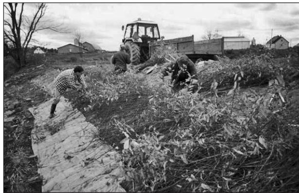
Photo 16 : Installation de matelas de branches
