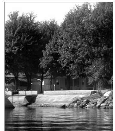
Photo 28 : Utilisation du faite du mur pour déterminer la ligne des hautes eaux
