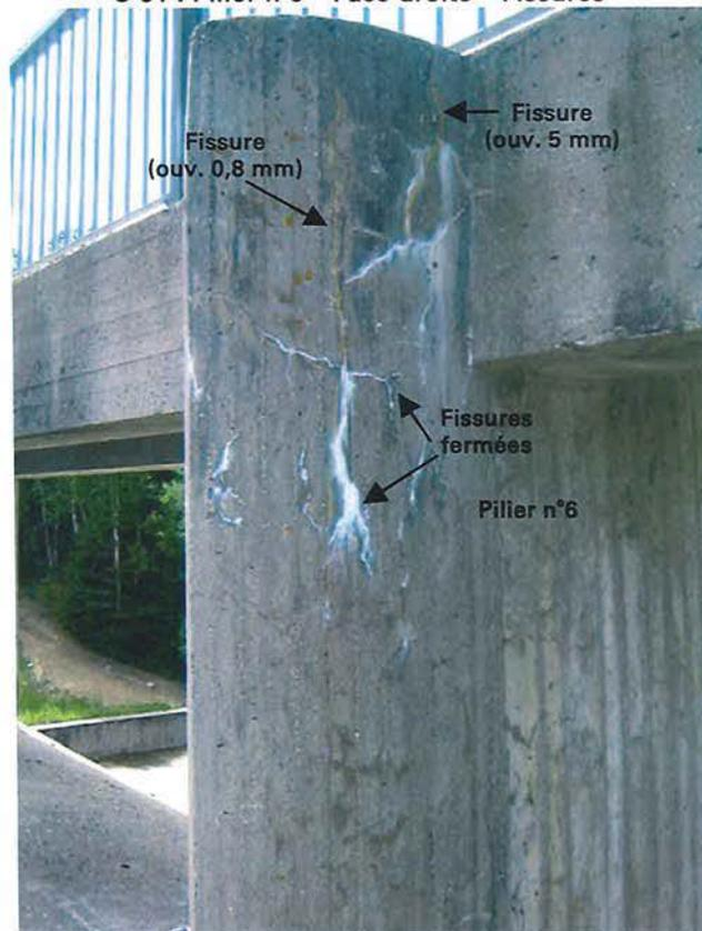
C-52 : Pilier n°6 – Face droite – Côté amont - Fissures
