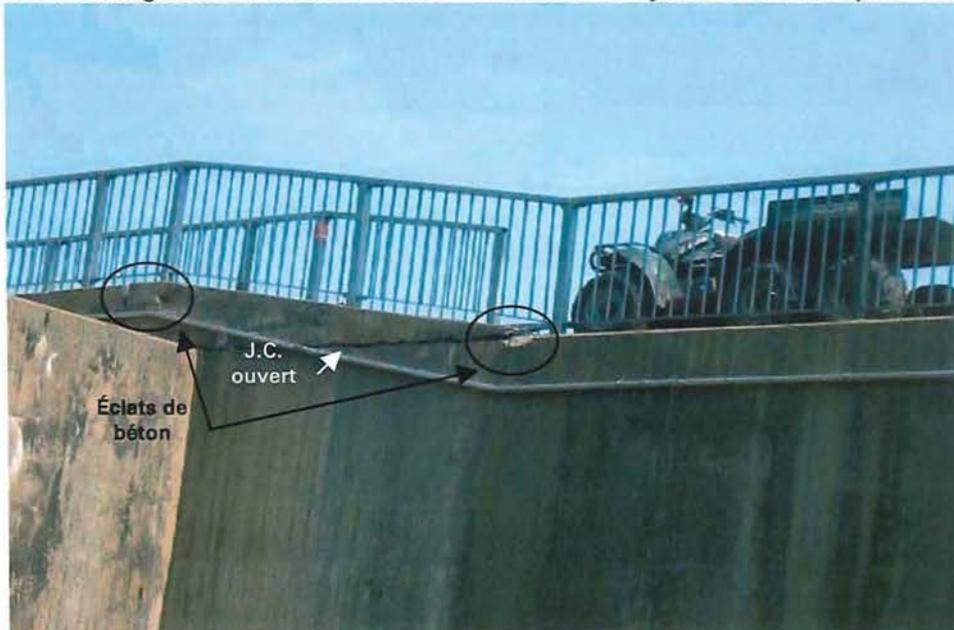
C-8 : Culée gauche – Face aval – Plot C – J.C. de la rampe d'accès ouvert et éclats de béton
