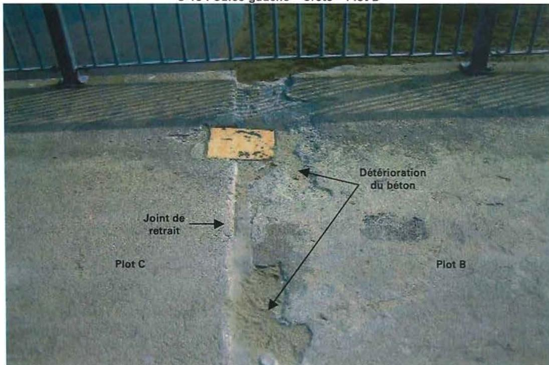
C-14 : Culée gauche – Crête – Joint de retrait au Plot B et C
