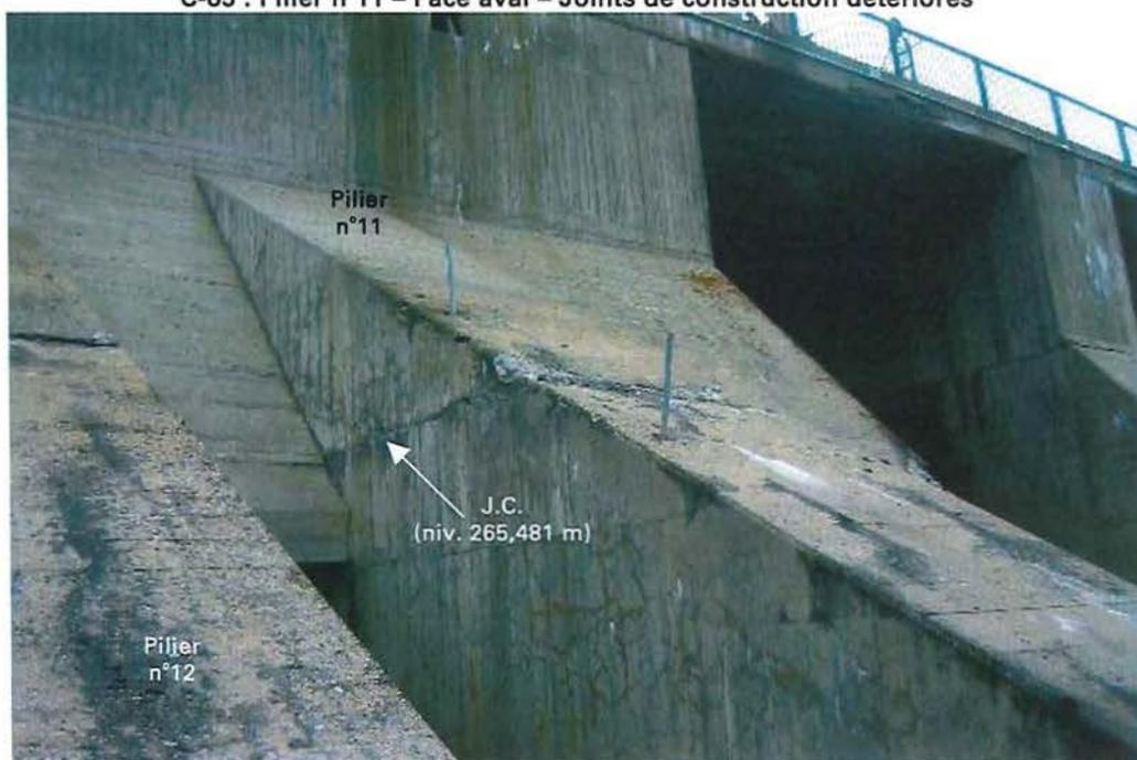
C-86 : Pilier n°11 – Face aval – Joint de construction détérioré
