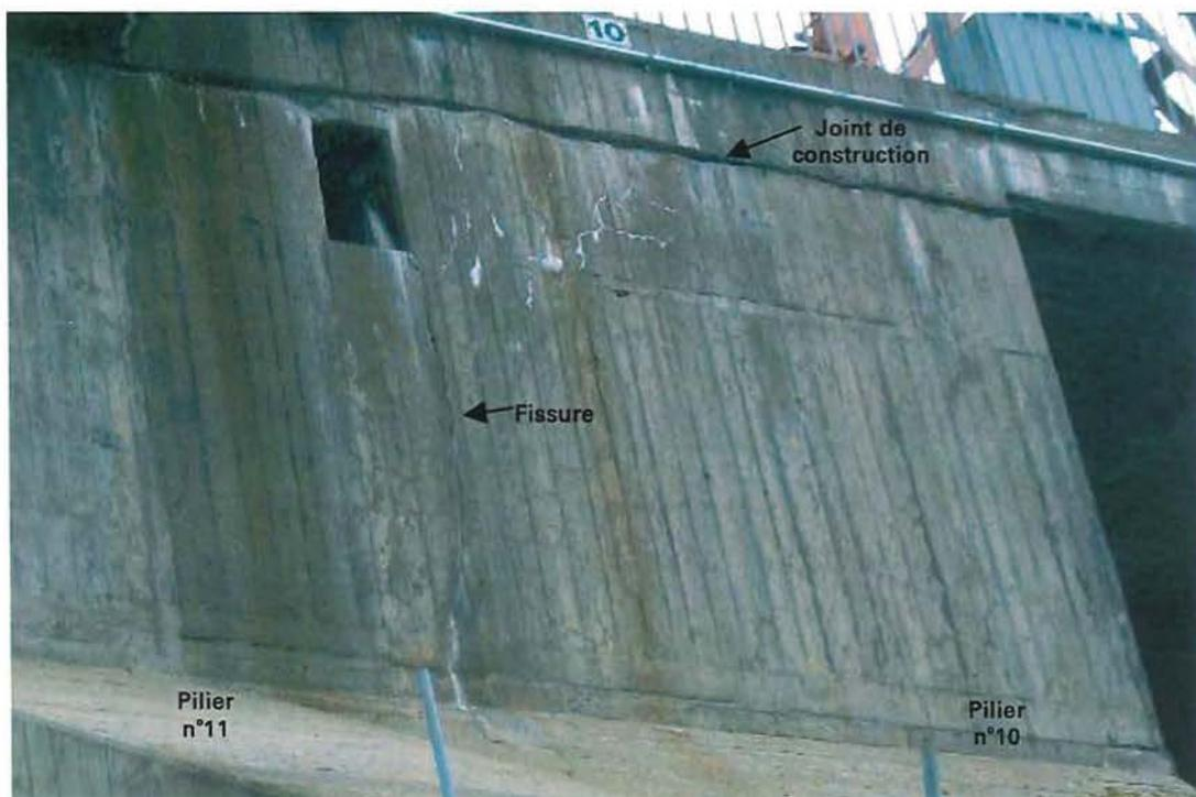
C-77 : Pilier n°10 – Face aval – J.C. détérioré et fissure
