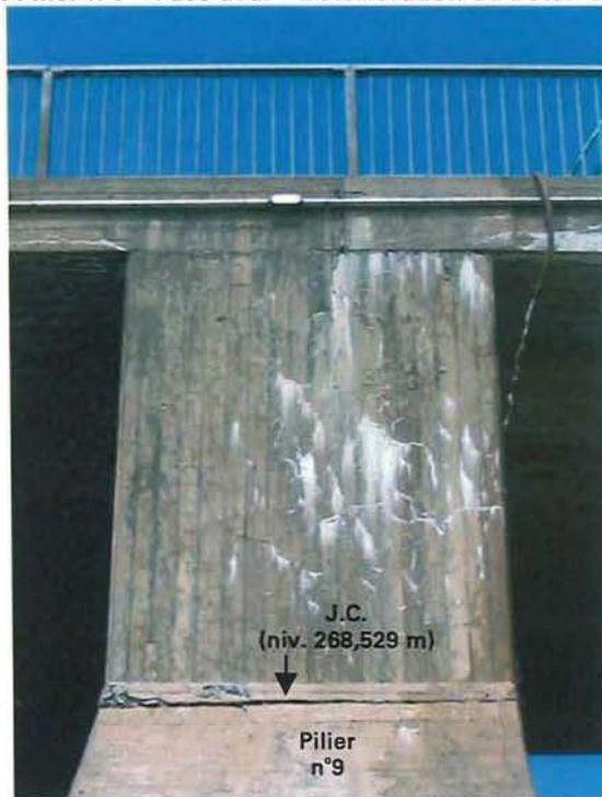
C-64 : Pilier n°9 – Face aval – Détérioration du béton au J.C.
