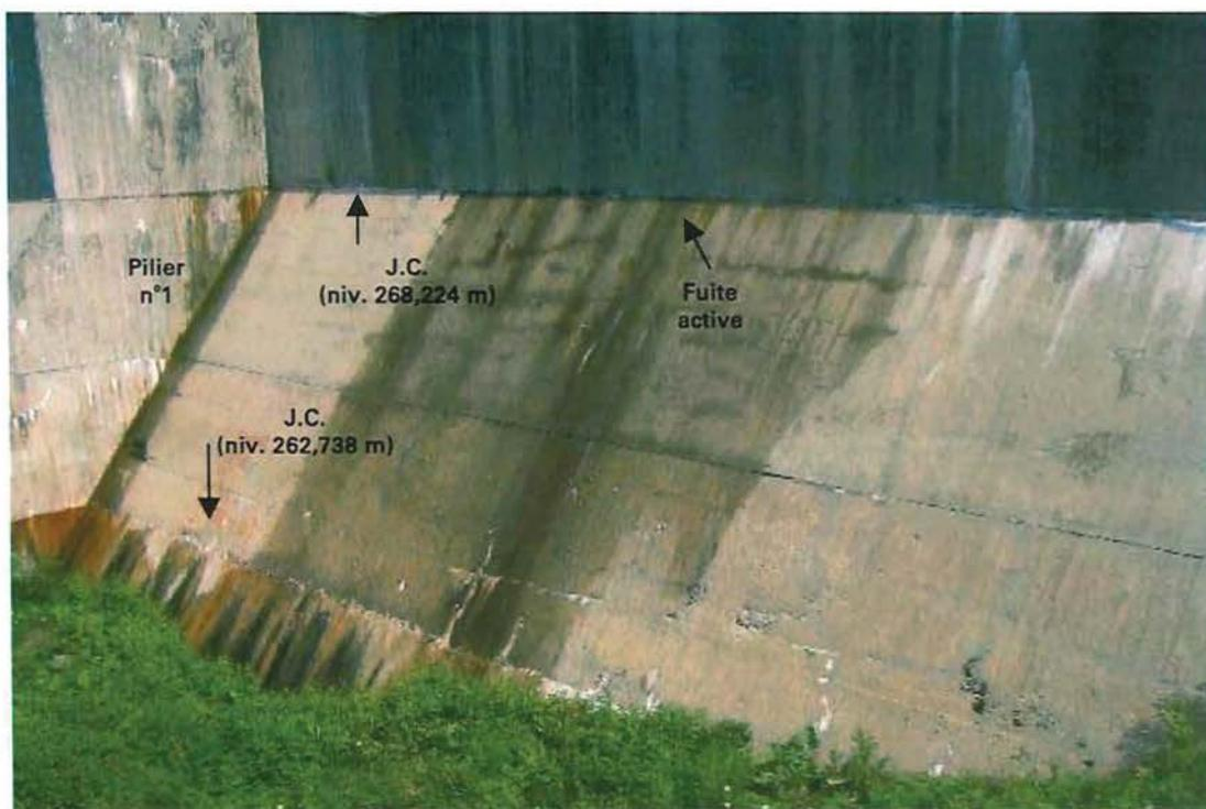
C-5 : Culée gauche – Face aval – Plot C – Suintement aux joints de construction (J.C.)
