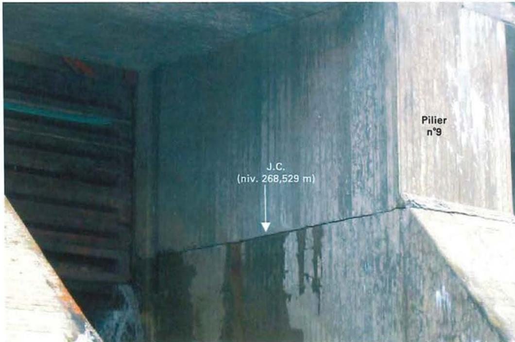
C-65 : Pilier n°9 – Face droite – Joint de construction ouvert avec suintement
