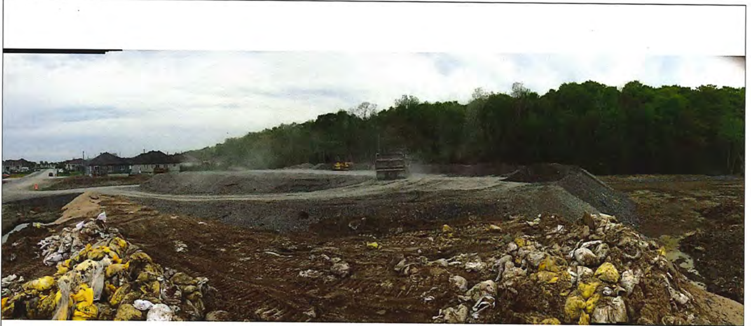
Photo 1: dépôt temporaire de gravier provenant de la digue temporaire.
