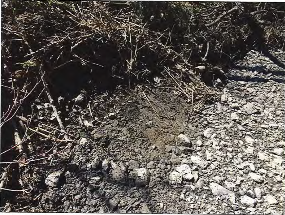
Photo 4: suintement d'eau entre la digue et la jetée.
