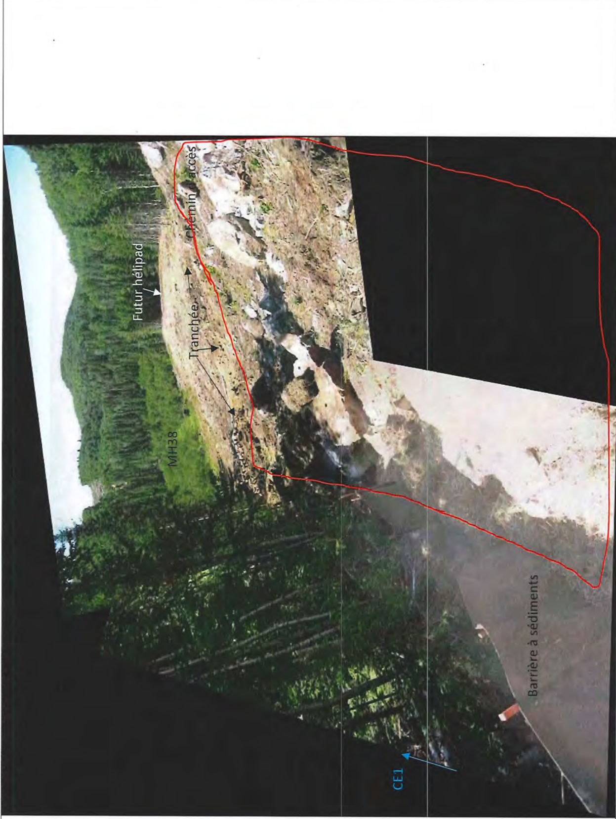
Photo 8: Chemin d'accès, futur hélipad, barrière à sédiments et paille installées suite aux événements des 5-6 juillet 2018, tranchée excavée au bas du chemin, vue direction sud-ouest vers le pylône 55 (GPS 081)
