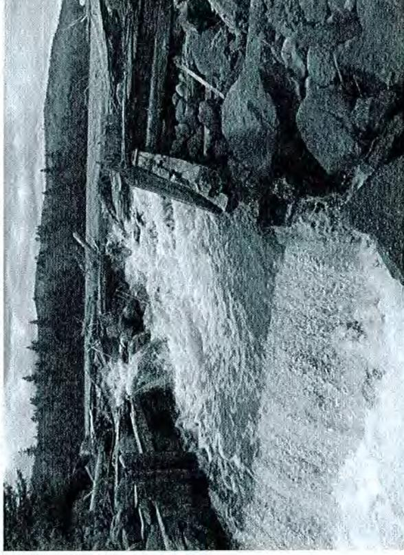
La roche et la toile semble rehausser le niveau d'eau, l'eau semble déverser plus large que la largeur du déversoir original à droite.
