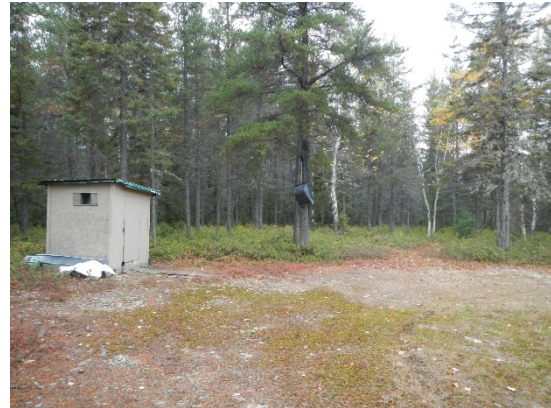
Photo 4. Vue dans la direction ouest
