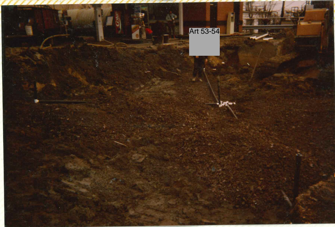
Photo 1: Remblai de gravier dans l'excavation des anciens réservoirs souterrains. Vue vers le nord-est. PV1 au premier plan, PV5 au centre, PV3 à l'arrière plan, PV2 du côté gauche du photo.
