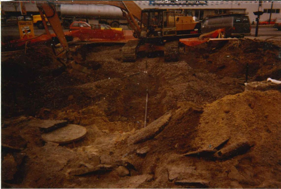
PHOTO 3: Installation du gravier au-dessus le réseau des tuyaux d'aspiration. Tuyau d'aspiration principal au premier plan. Vue
