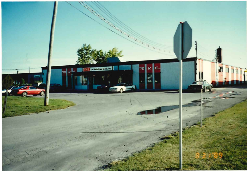
VUE GÉNÉRALE ENTRÉE PRINCIPALE
