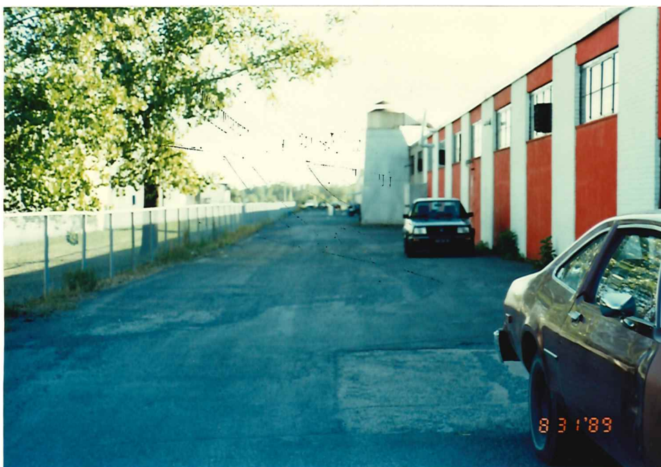
VUE GÉNÉRALE, CÔTÉ OUEST DU BATIMENT .
