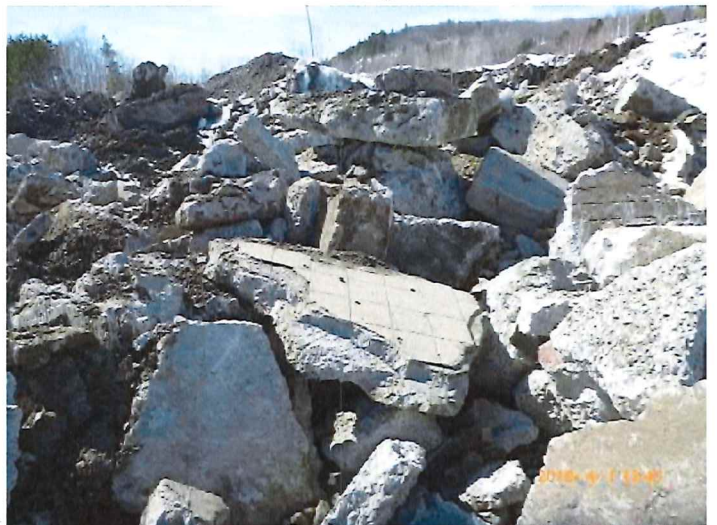
P1040374.JPG Photo 6. Vue rapproché d'un amas de béton
