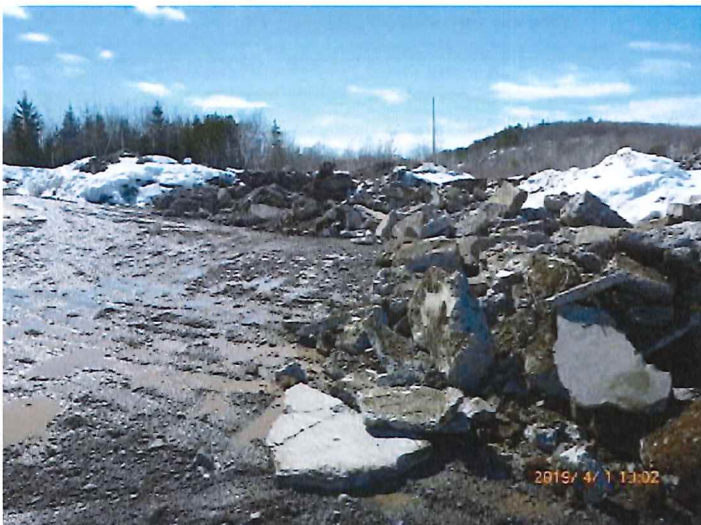
P1040379.JPG Photo 5. Amas récent de béton
