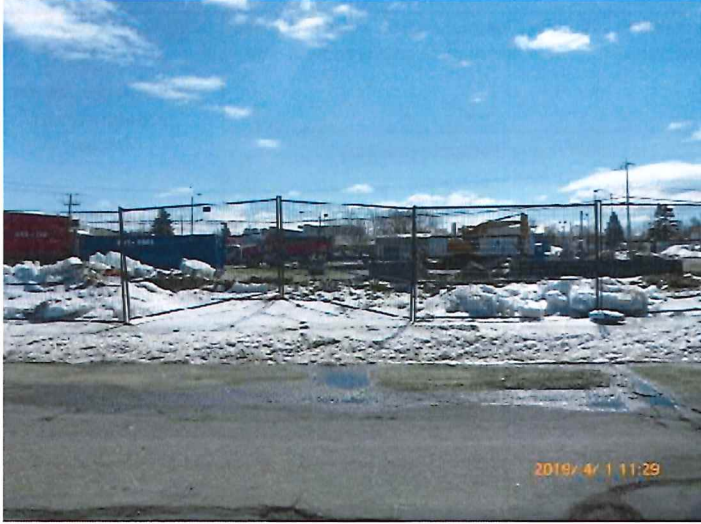
P1040357.JPG Photo 1. 5, boulevard Taché Ouest, avec camion-benne et rétrocaveuse en action
