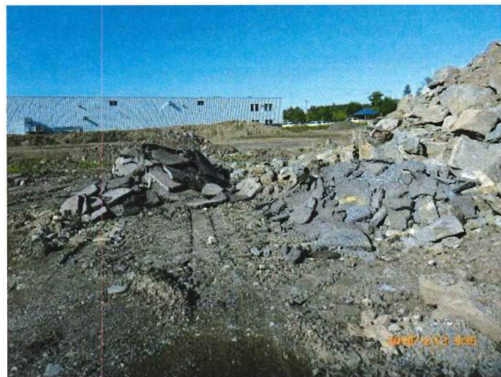
P1040789.JPG Photo 6. Amas d'asphalte
