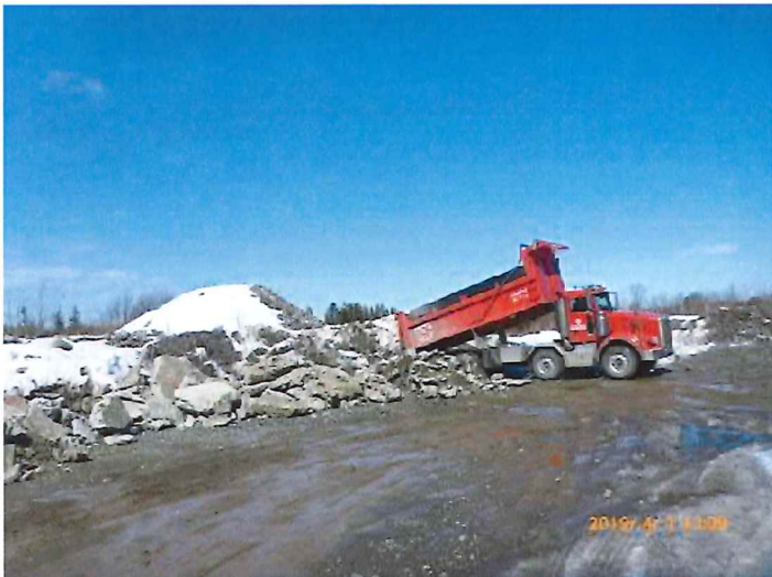
P1040382.JPG Photo 7. Camion-benne déchargeant du béton
