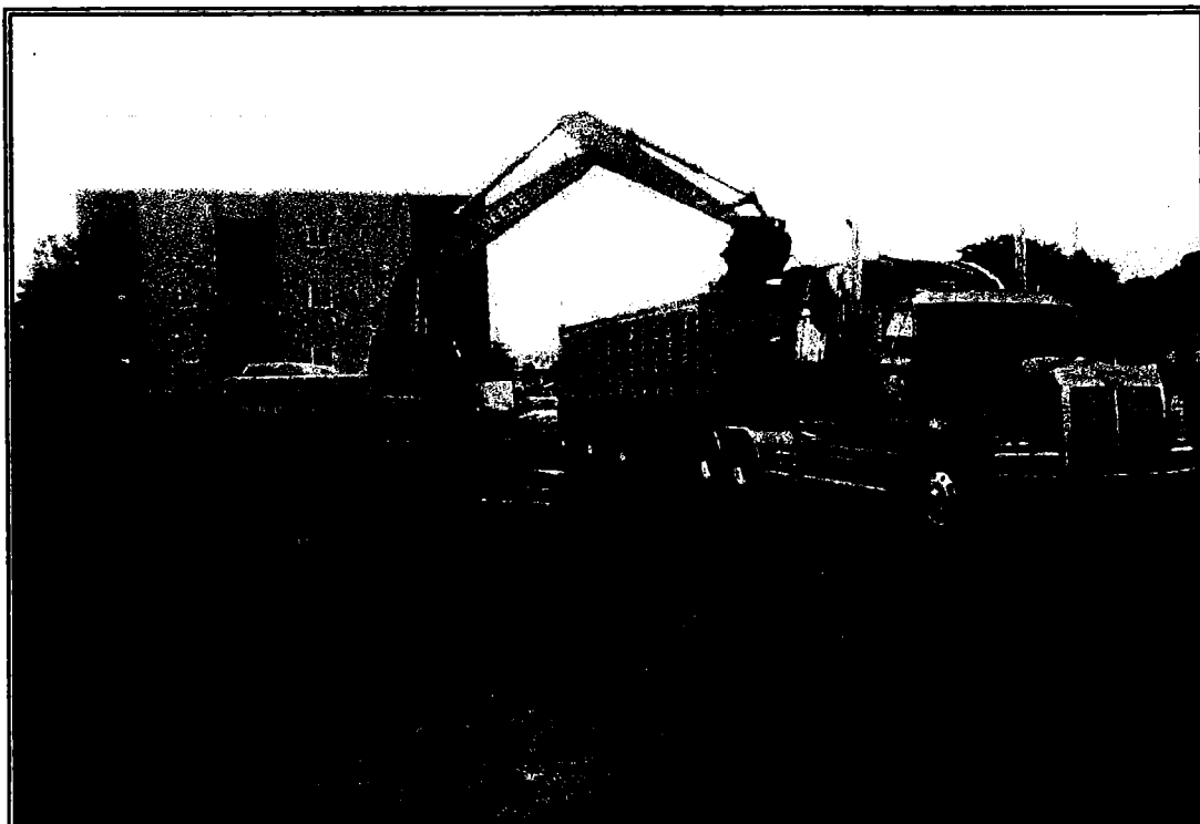
PHOTOGRAPHIE 3 : Chargement de l'empilement EMP-4. Vue vers le sud.
