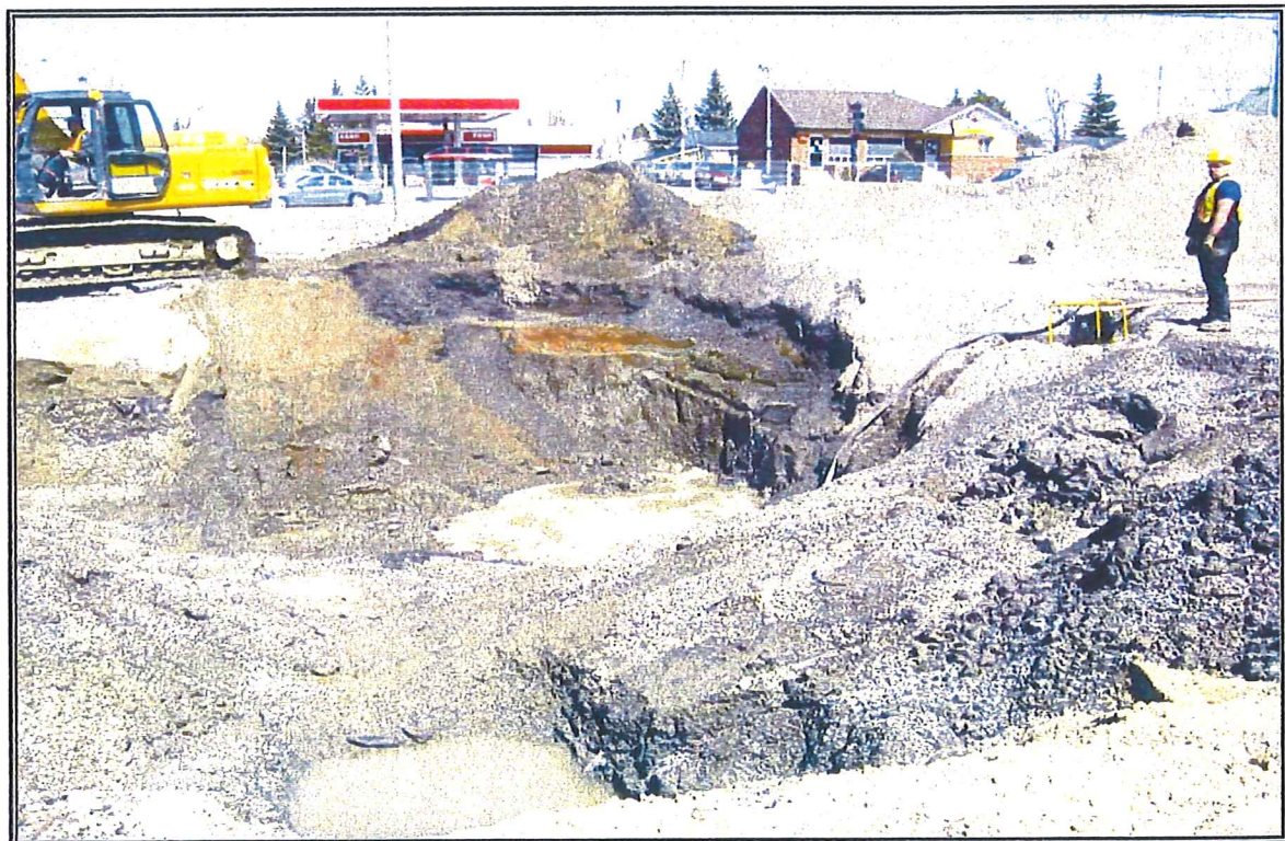
PHOTO 4: Excavation des matériaux de remblai présents dans l'ancienne fosse des réservoirs et pompage de l'eau présente dans l'excavation. Vue en direction ouest.
