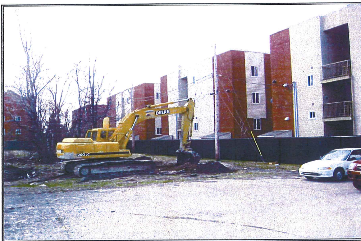
PHOTO 7: Réalisation de la tranchée d'exploration TE-08-07 dans le secteur de l'ancien dépanneur. Vue en direction est.
