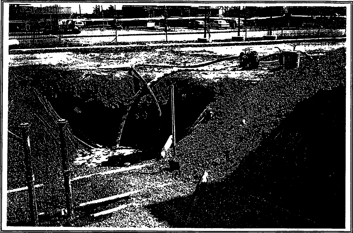
PHOTO 3: Pompage de l'eau de la fosse.
