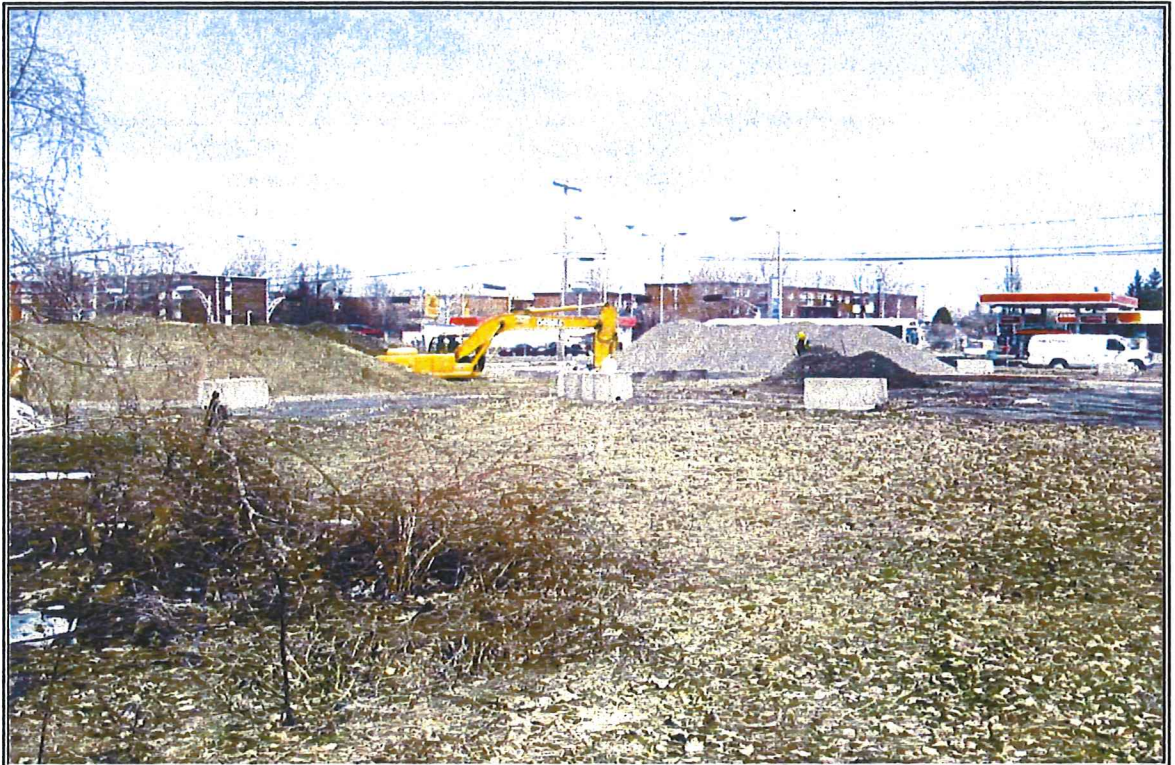
PHOTO 2: Vue d'ensemble du site lors des travaux. Vue en direction du nord-ouest.
