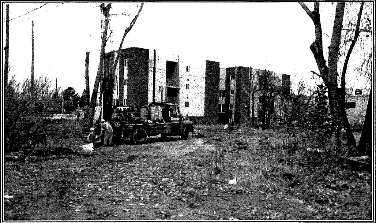
PHOTO 3: Mise en place du puits d'observation PO-01-7, vue vers le nord-ouest.
