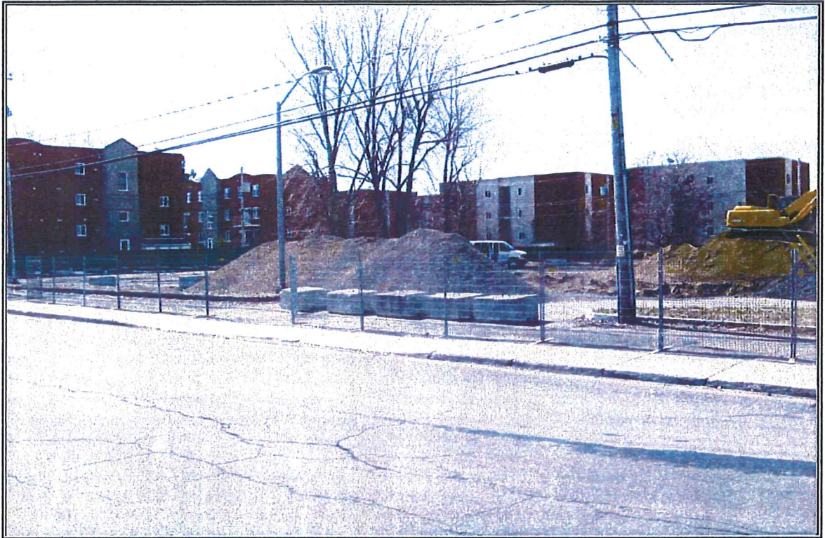
PHOTO 1: Vue d'ensemble du site lors des travaux. Vue en direction du sud-est.
