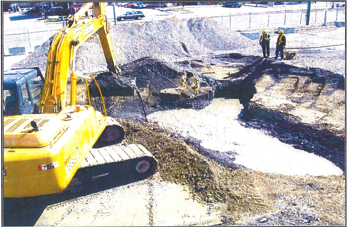
PHOTO 3: Excavation des matériaux de remblai présents dans l'ancienne fosse des réservoirs et pompage de l'eau présente dans l'excavation. Vue en direction nord.
