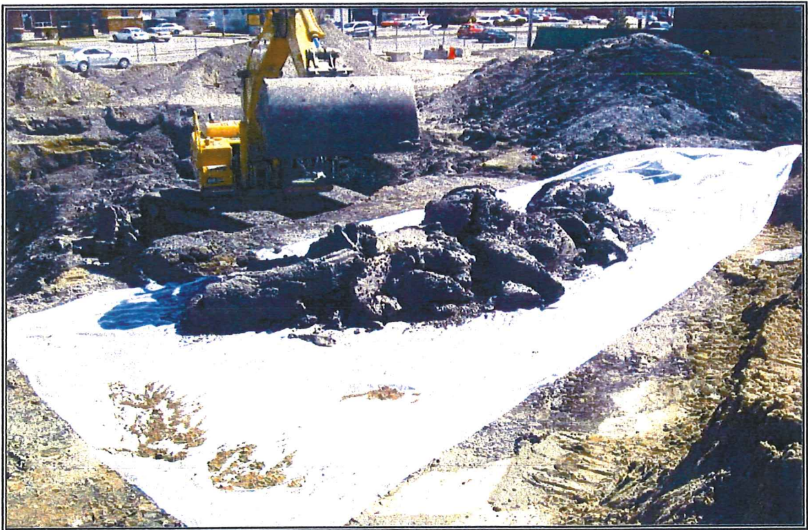
PHOTO 6: Mise en piles des sols affectés sur des membranes de polythène.
