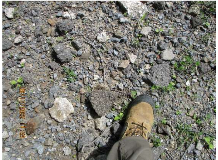
IMG_0777.JPG Détail des rebuts de construction.
