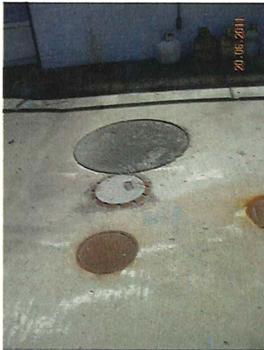
Emplacement du réservoir
