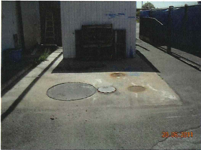
Emplacement des réservoirs de mazout et d'huile usée (abandonnés)
