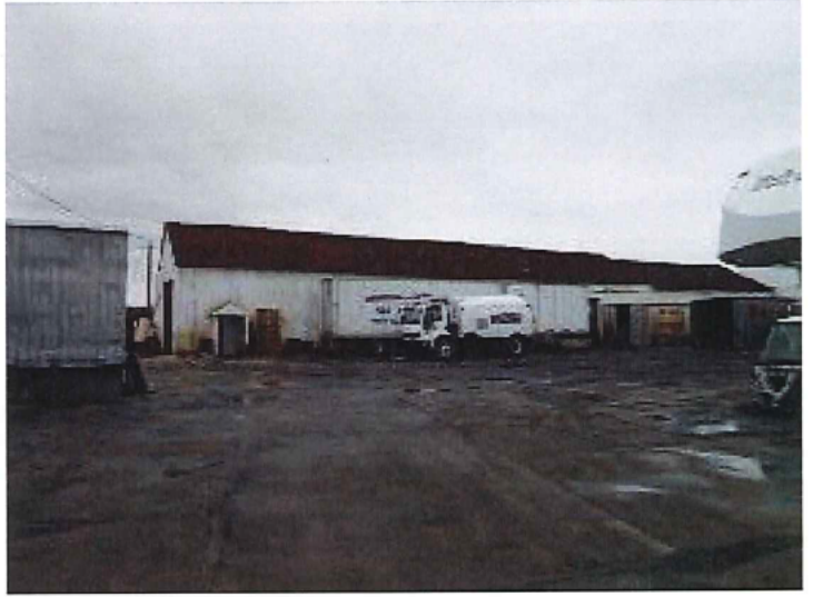
Art. 23-24 (640x480).jpg camion pompage pas identifié au nom de la Cie.
