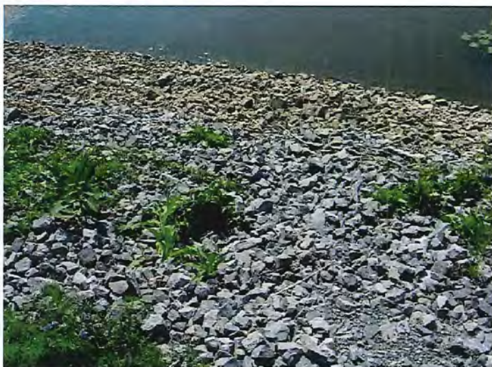
(photo 6)IMG_4510.JPG enrochement brise-lame Est
