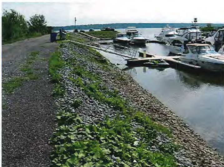
(photo 4)IMG_4507.JPG enrochement brise-lame Est
