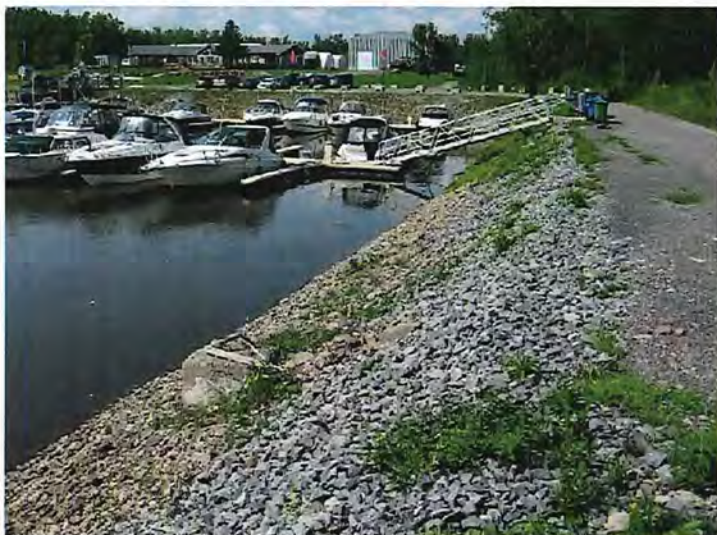
(photo 5)IMG_4513.JPG enrochement brise-lame Est
