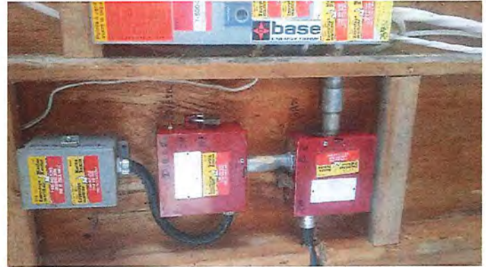
20210708_142801.jpg (Photo 2 : système de détection de fuite)
