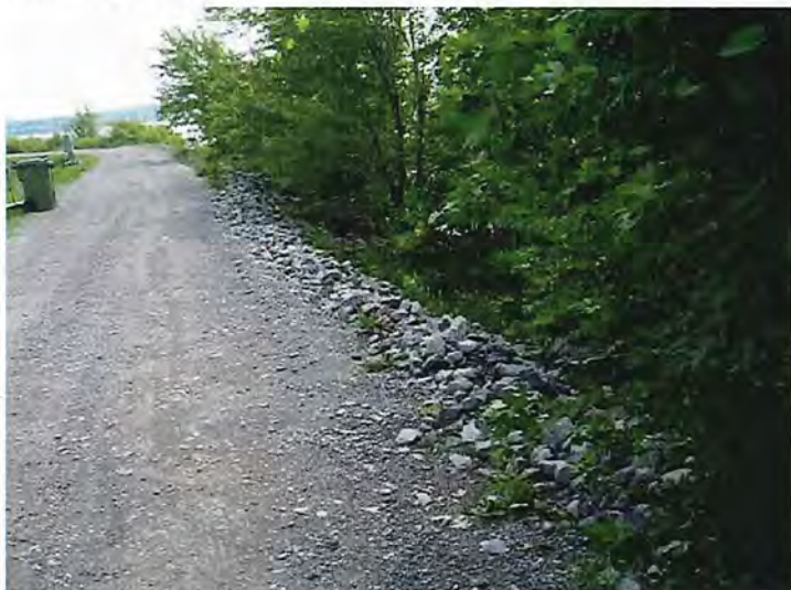
(photo 3)IMG_4506.JPG enrochement brise-lame Ouest
