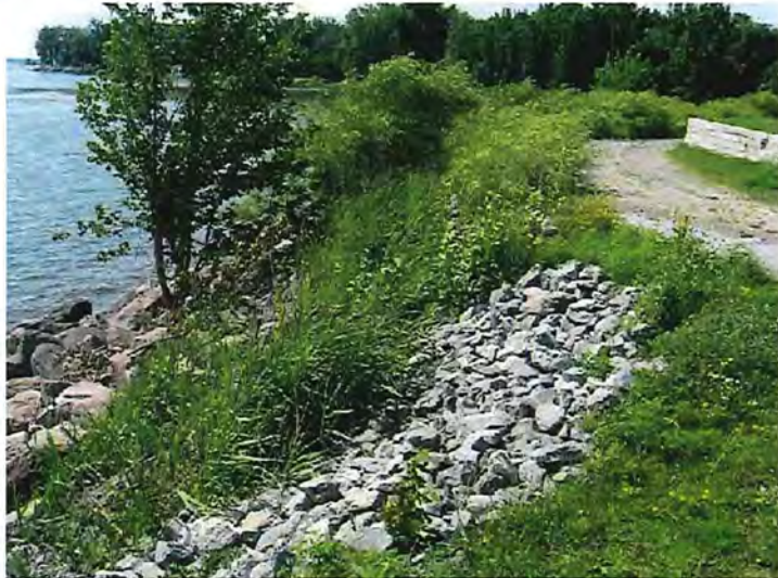
(photo 2)IMG_4499.JPG enrochement brise-lame Ouest
