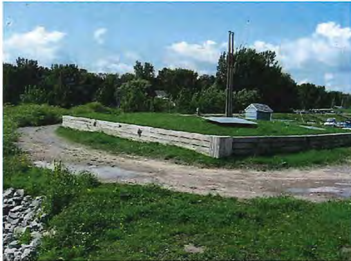
(photo 1)IMG_4500.JPG réservoirs d'hydrocarbures enfouis dans le brise-lame Ouest
