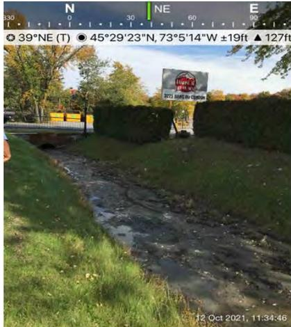
Photo 20211012\_153447602\_iOS.jpg : Fossé en remontant vers le nord (en aval) du conteneur de pulpe de pomme est rempli de boues et de rejet liquide à proximité du Camping au Pied du Mont
