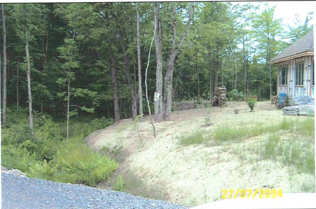
Photo# 4. Remblayage de la rive et du littoral au point 4
