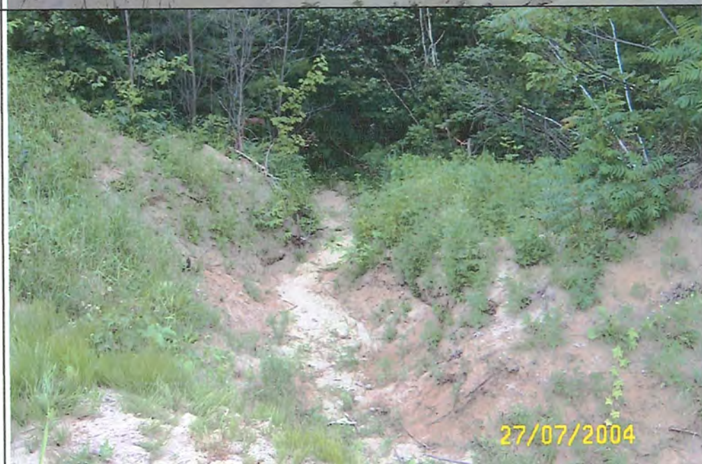
Photo# 6. Fossé de drainage aménagé au point 5. Beaucoup de sédiments dans ce fossé qui se dirige vers la rivière.
