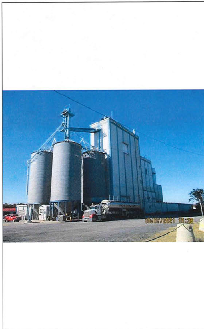
IMG_0412 (640x480).jpg Meunerie vue éloignée
