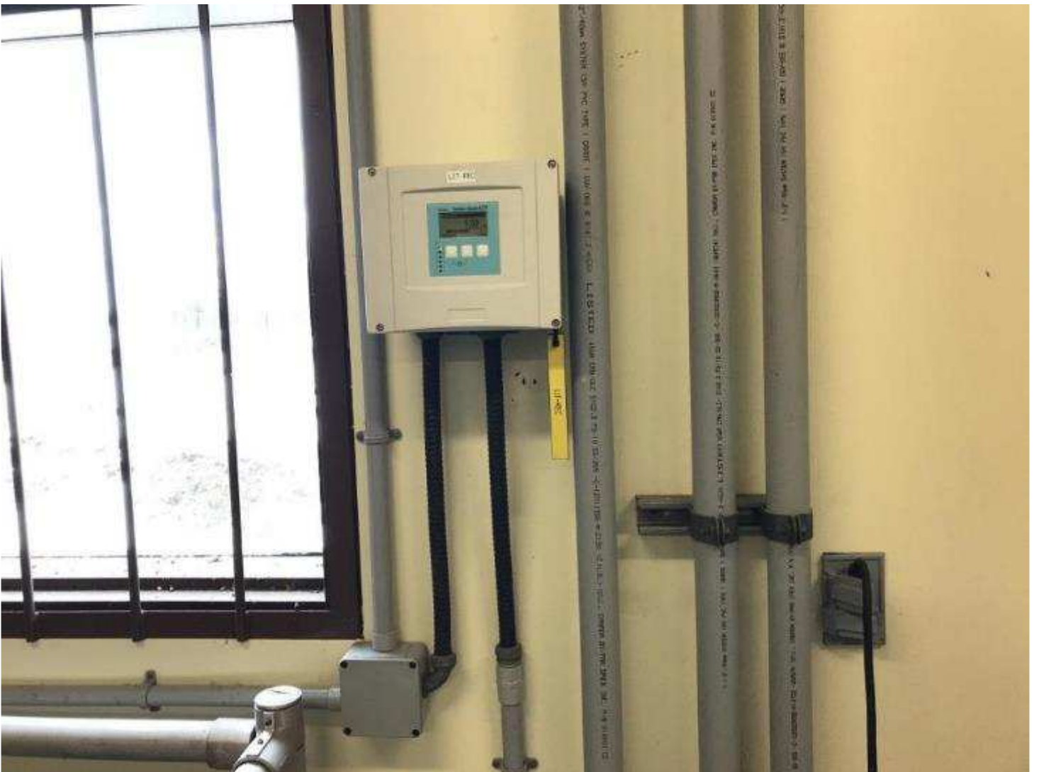
32-IMG_0413.JPG – Niveau de la réserve au moment de l'inspection
