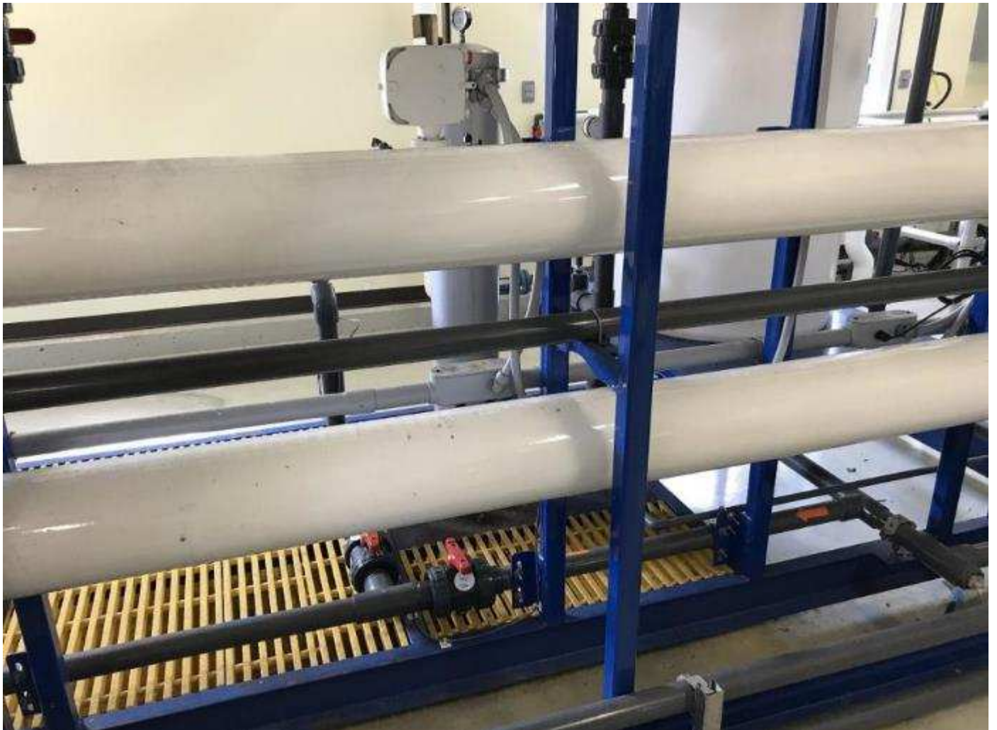
22-IMG_0403.JPG – Deux nouvelles colonnes de filtration membranaire datant de février 2021
