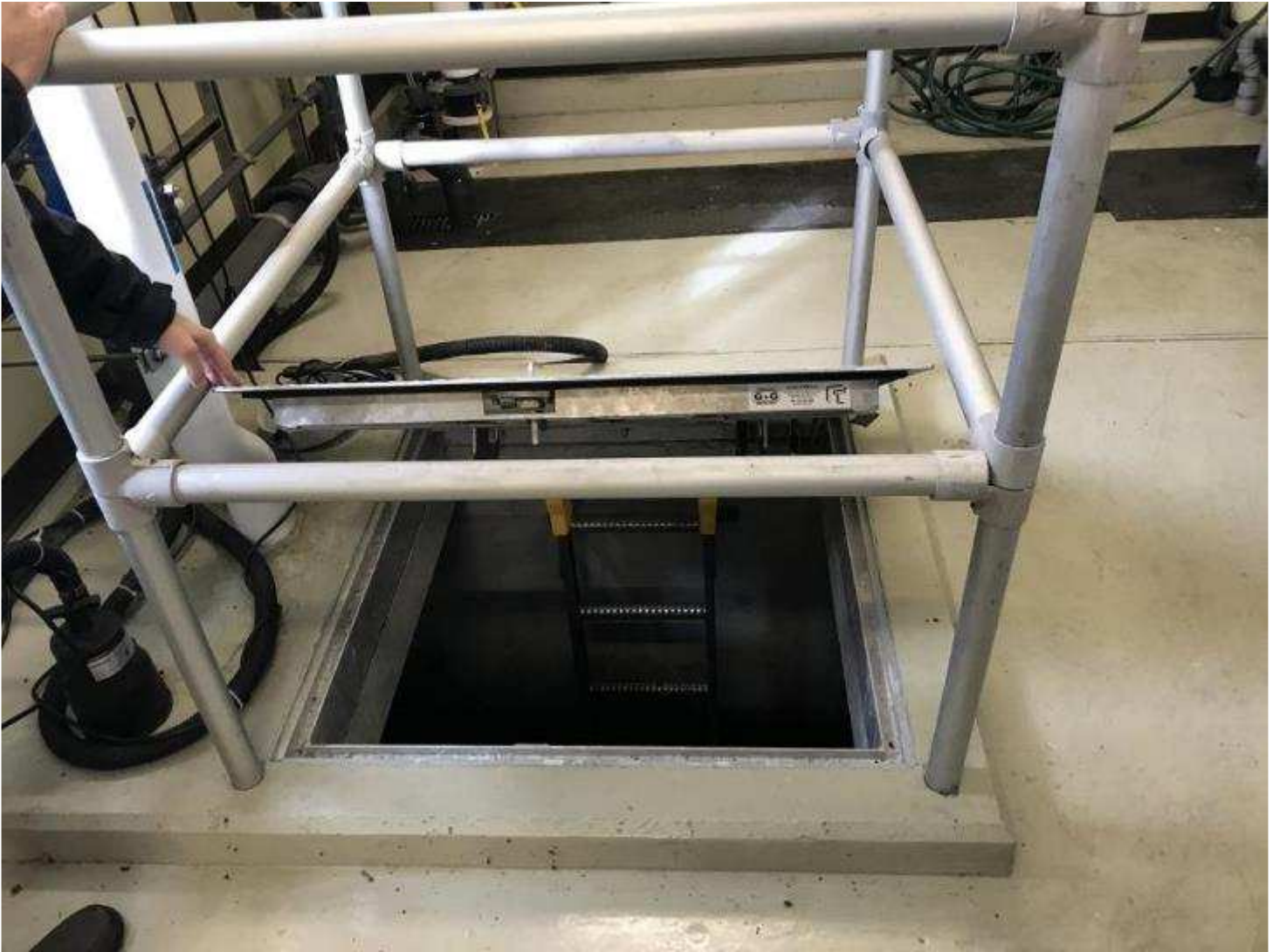
31-IMG_0412.JPG – Trappe étanche assurant l'accès au deuxième compartiment de la réserve.
