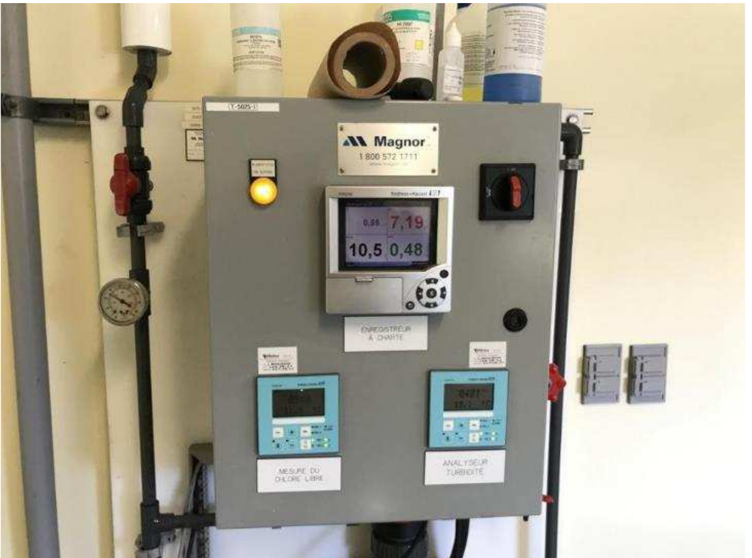
4-IMG_0385.JPG – Afficheur et enregistreur de données
