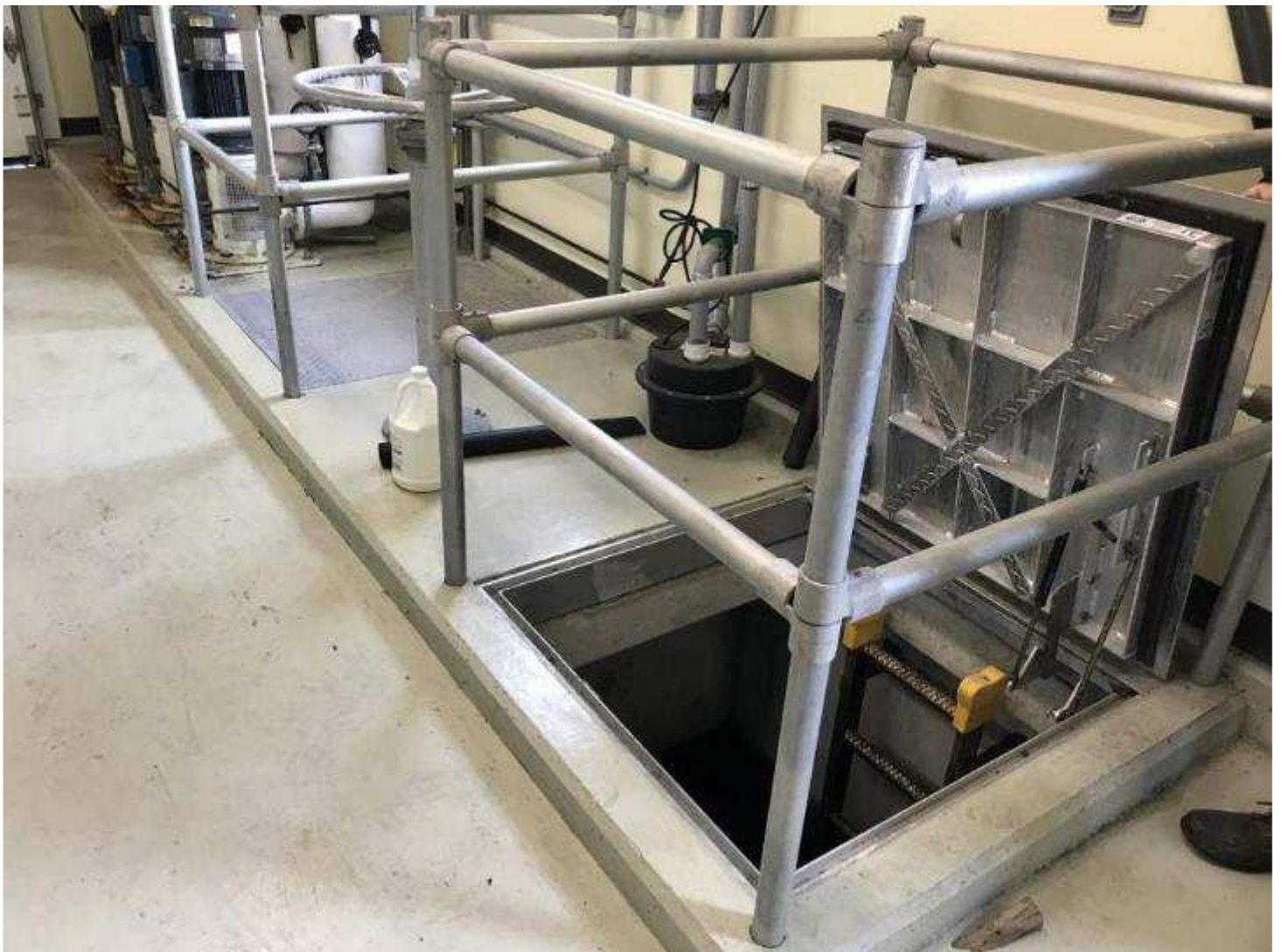
30-IMG_0411.JPG - Deux trappes étanches assurant l'accès au premier compartiment de la réserve
