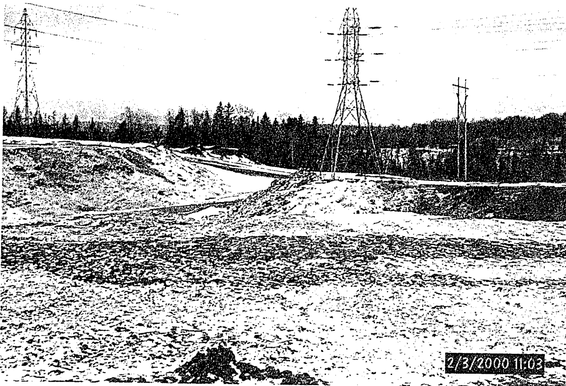
Photo no 4 : Site du garage municipal à Mont-Laurier. Rue Godard. Lieu en exploitation.
