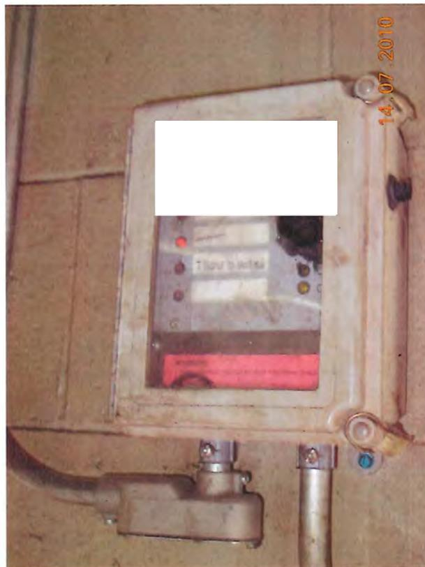
Panneau de contrôle du système de détection de fuite du réservoir.
