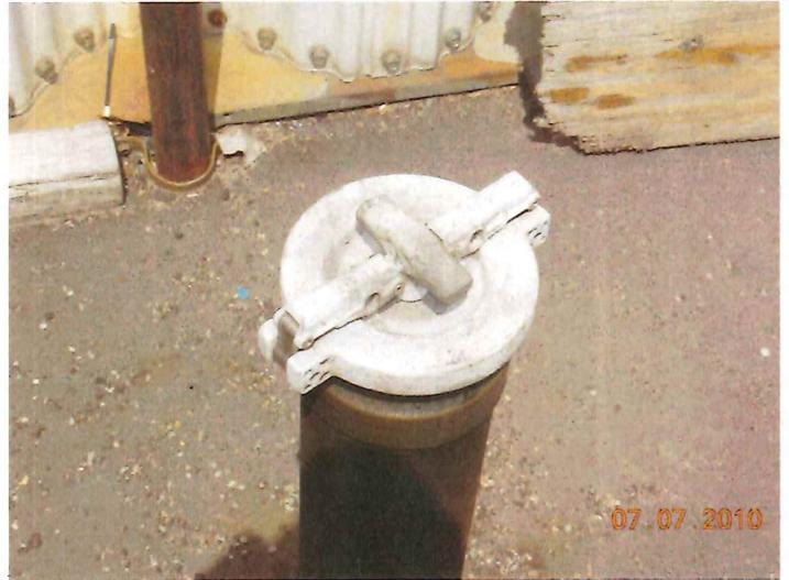
Système de verrouillage de la tuyauterie présent en dehors des périodes de vidange du réservoir souterrain.
