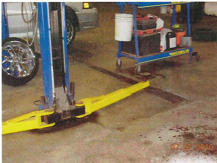
Réseau de drainage du plancher présent dans le garage et relié à un séparateur eau/huile.
