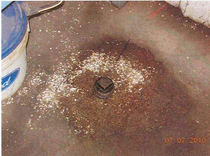
Embouchure de la tuyauterie servant au transfert de l'huile usée. Granules absorbantes sur le plancher environnant.
