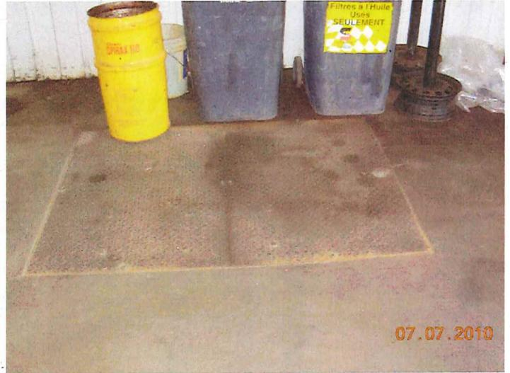
Trappe du séparateur eau/huile. Ce dernier est relié aux drains de plancher du garage.
