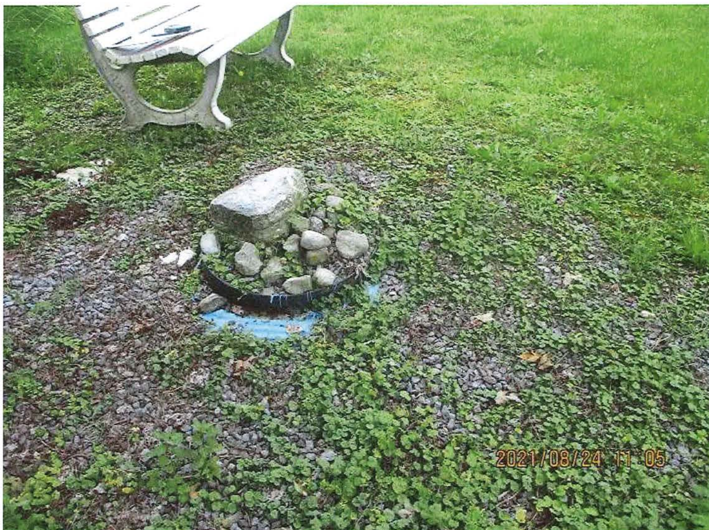
IMG_1887.JPG Branchement des eaux usées, terrain 114, semble se diriger dans un baril.
