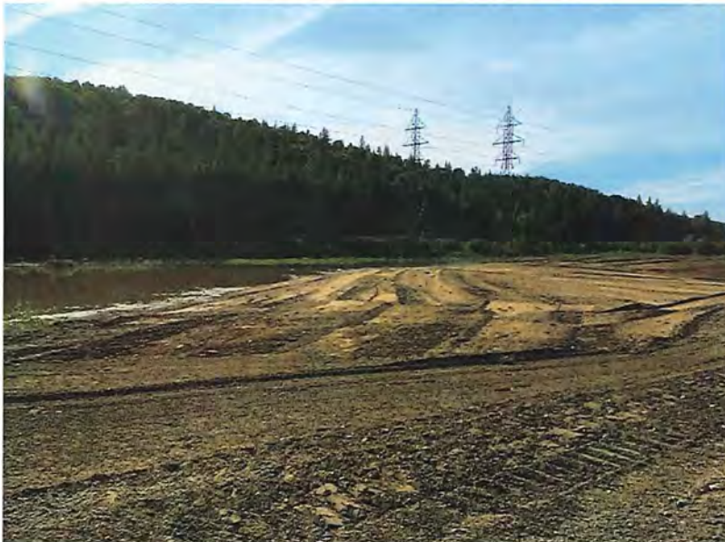
2. Photo transmise par la municipalit  d'une partie de la zone des travaux (photo 3.JPG).
