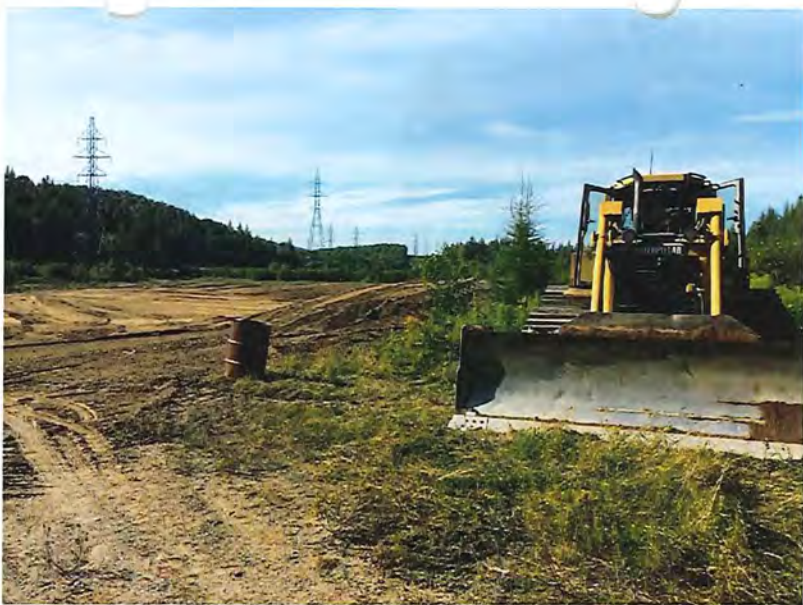
1. Photo transmise par la municipalit  d'un bulldozer et d'une partie de la zone des travaux (photo 2.JPG).
