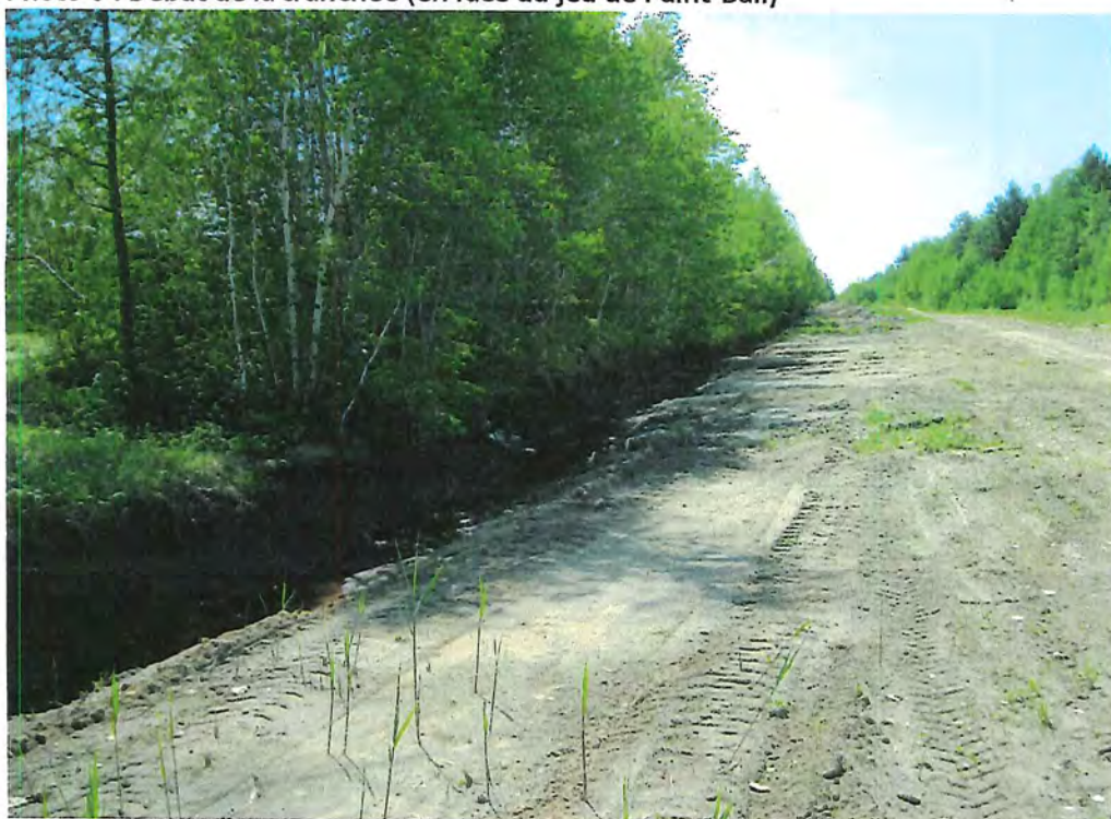
Photo 7 : Tranchée de drainage
