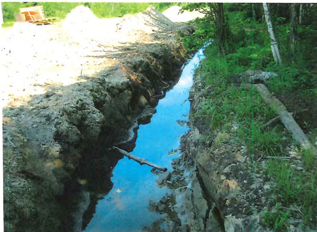
Photo 6 : Début de la tranchée (en face du jeu de Paint-Ball)
